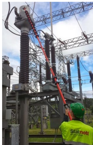
Bruk av kamera med isolerstang.
