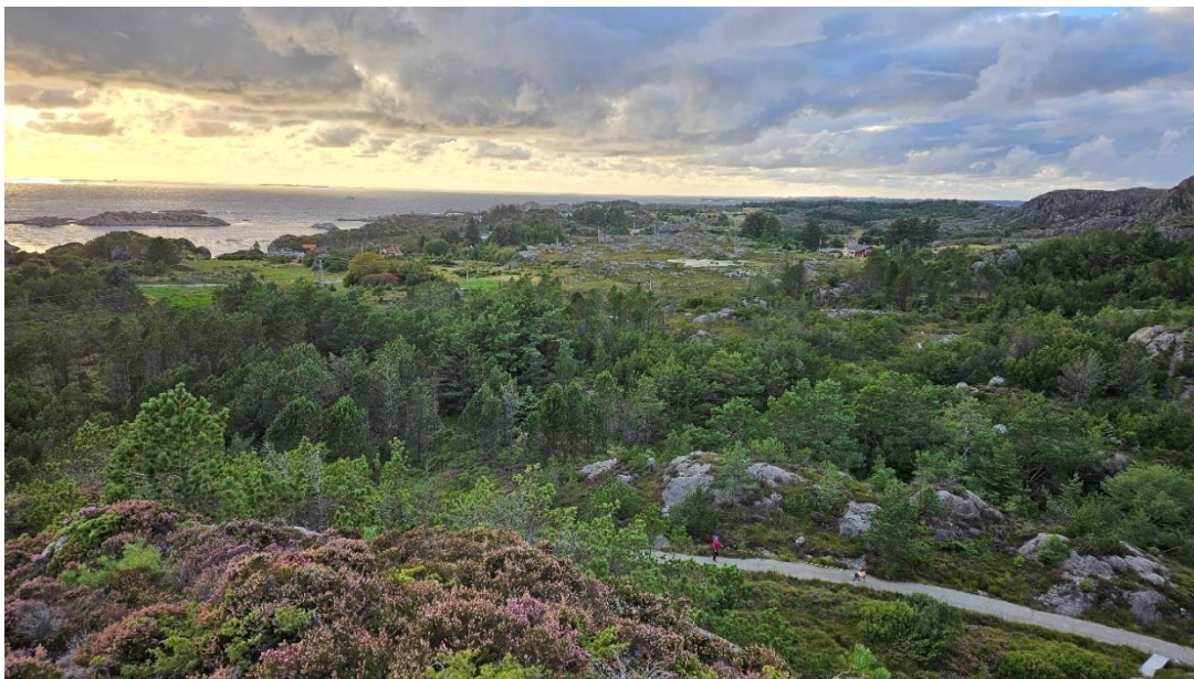
Figur 5-4. Bildet er tatt mot stasjonsområdet for transformatorstasjon 2A.
