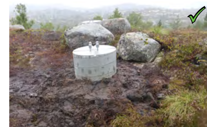
Figur 20: God overgang mellom stabbe og terreng.
