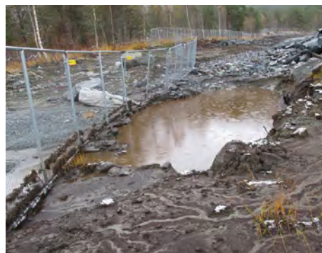
Figur 41: Enkelt sedimentasjonsbasseng for oppsamling av sand og gruspartikler. Viktig at de blir tømt regelmessig, for å opprettholde funksjonen.
