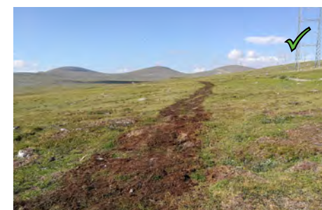
Figur 33: Godt istandsatt kjørespor.
