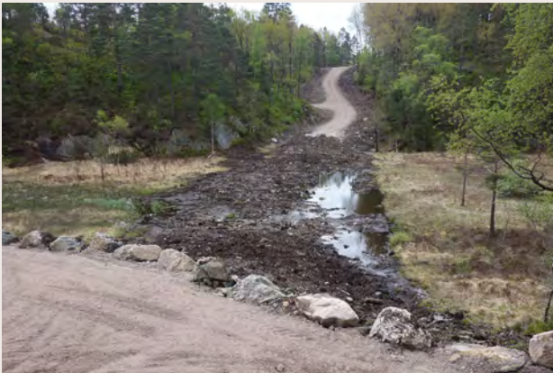
Figur 2 Arbeid i urørt terreng krever kunnskap om terrengbehandling i ulike typer landskap. Her måtte veien følge kanten av myra istedet for å krysse rett over fordi myra hadde dårligere bæreevne enn først antatt.
