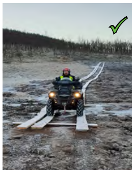
Figur 10: Eksempel på etablert terrengforsterkning over bløte partier.
