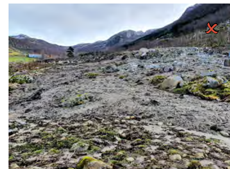
Figur 15: Baseplassen er etablert uten tilstrekkelig kontroll med avrenning. Bløte masser har glidd ut og mengder med finstoff har blitt fraktet over terreng og ned til et vassdrag. Det har ikke vært etablert tilstrekkelig med avskjærende grøfter for å håndtere intensive nedbørsperioder.
