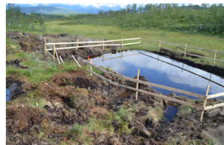
Figur 39: Etabler sedimentsasjonsbasseng for håndtering av vann fra byggegrøp for mastepunkt. Bassenget fylles igjen etter bruk..
