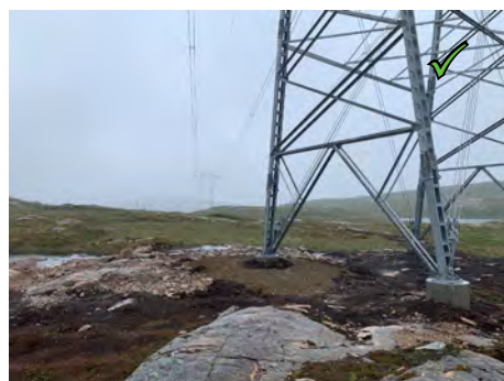
Figur 22: Her er sprengsteinsblokk fjernet fra overflaten.
