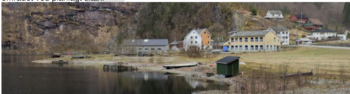
Figur 13: Eidslandet i Vaksdal kommune. Fylkesvei 569 hvor transformatortransporten skal gå vises i bakgrunnen i bildet
