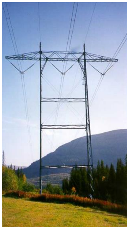
Figur 3: Mast med isolatorkjeder i V-form, og til høyre mast med trekantoppheng. Foto: Statnett
