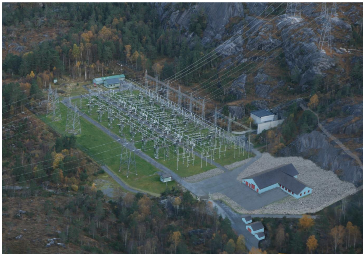
Figur 22: Oversiktsbilde over Blåfalli koblingsstasjon sett fra sør, med visualisering av omsøkte utvidelser med nytt bryterfelt og nytt kontrollhus.
