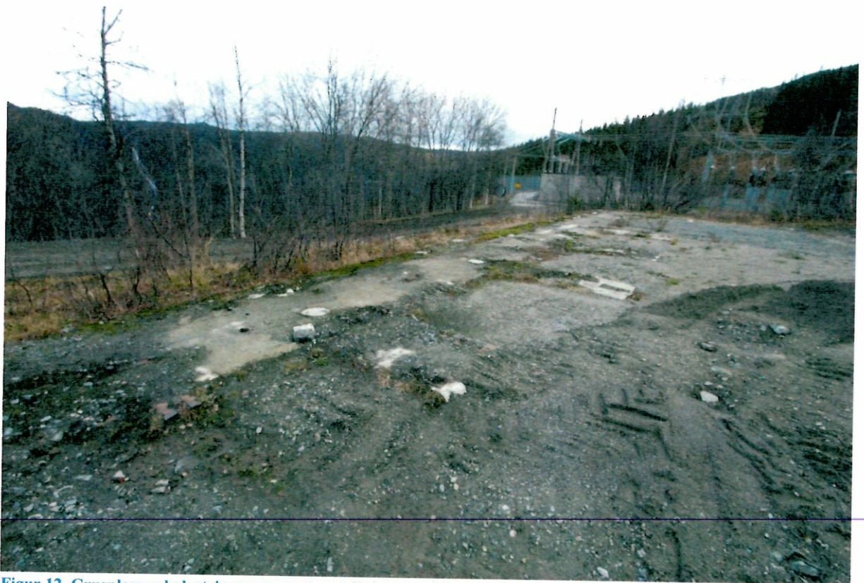
Figur 12. Grusplassen bak steinmuren er et restriksjonsområde, men kan benyttes til lagring av lettere utstyr og materiell under anleggsperioden.
