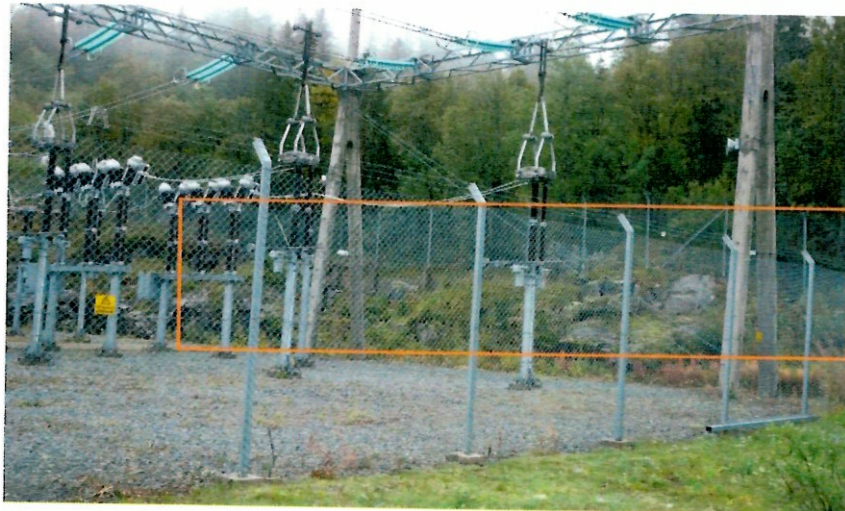
Figur 9. Område for planlagt avskjærende grøft mellom koblingsanlegg og vei.
