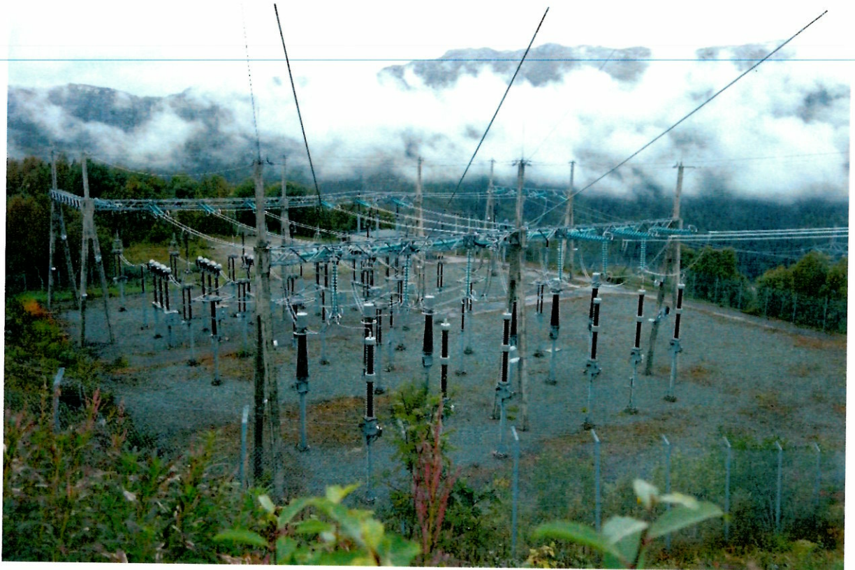
Figur 4. Anlegget på Vemorktoppen som skal rives.
