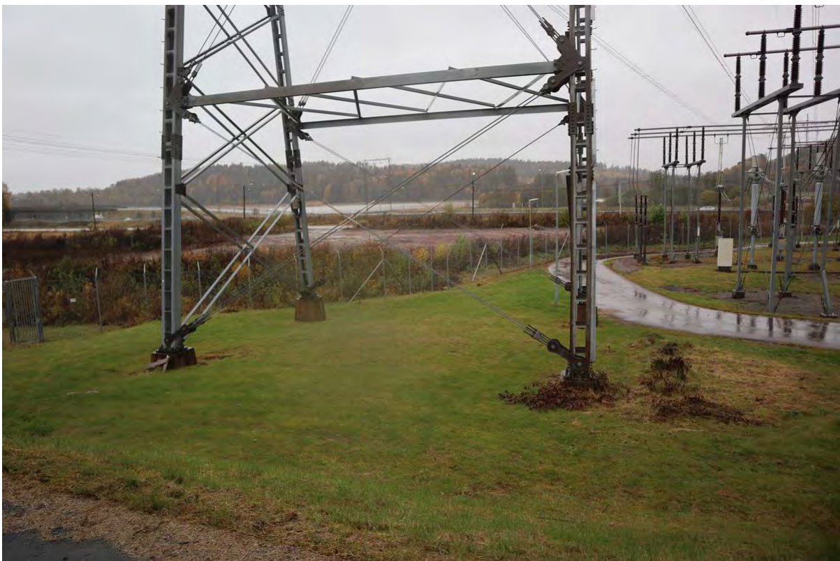
Figur 3. Oversikt mot sørvest og Statnetts eiendom som søkes brukt til utvidelse av stasjonen. Nærmeste samleskinne (300 kV) vil bli vinklet for å unngå 420 kV -masten i forgrunnen.
