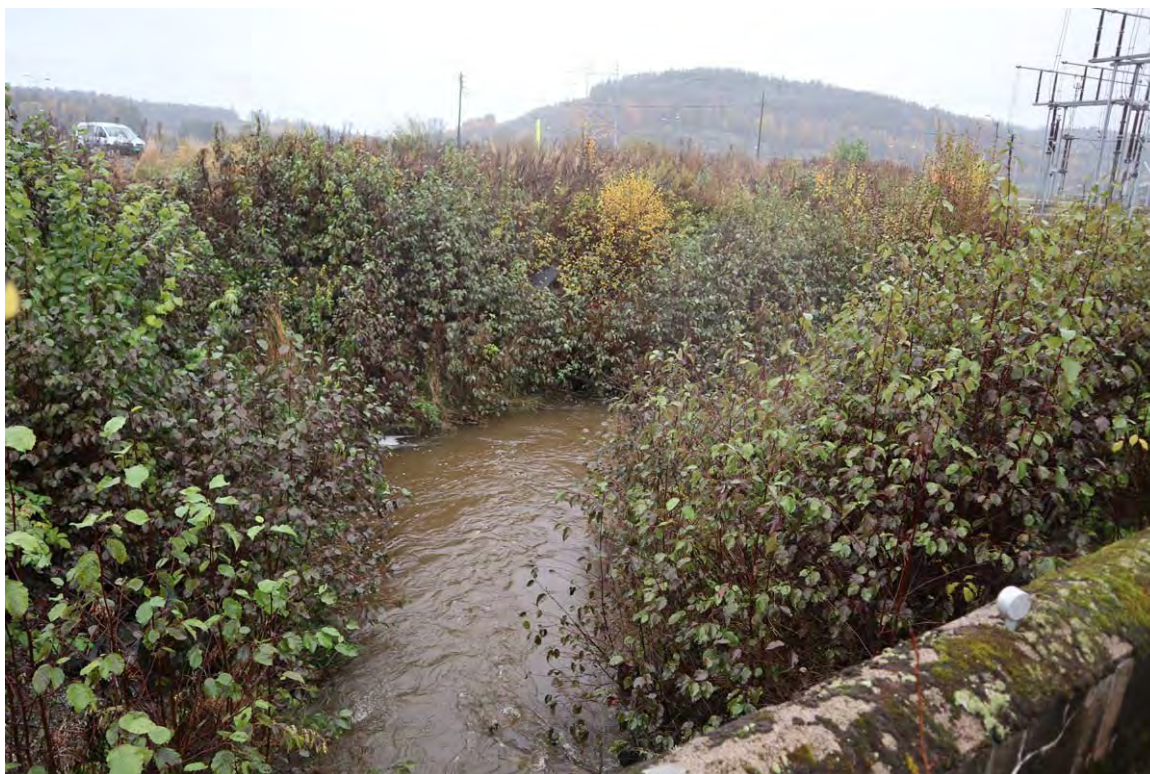
Figur 4. Tveitenbekken sett mot vest ved stor vannføring. Stasjonen til høyre. Tresjiktet i kantsonen er ryddet. I forkant skimtes broen som skal rives.
