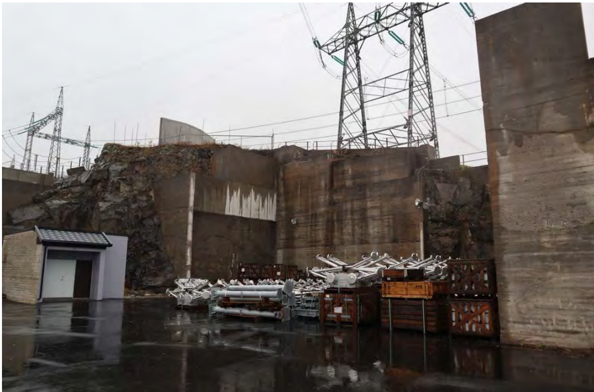
Figur 6: Ledig plass i tidligere transformatorsjakt til ny sjakt og T6 transformator.
