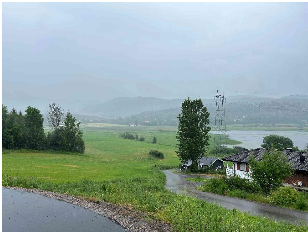
Figur 17 Nordlig del av Børsesjø naturreservat sett fra vest mot øst. Eksisterende 300 kV kraftledning krysser i dag vernegrensen, og regionalnett krysser i dag i utkanten av naturreservatet. Bilde: Statnett.
