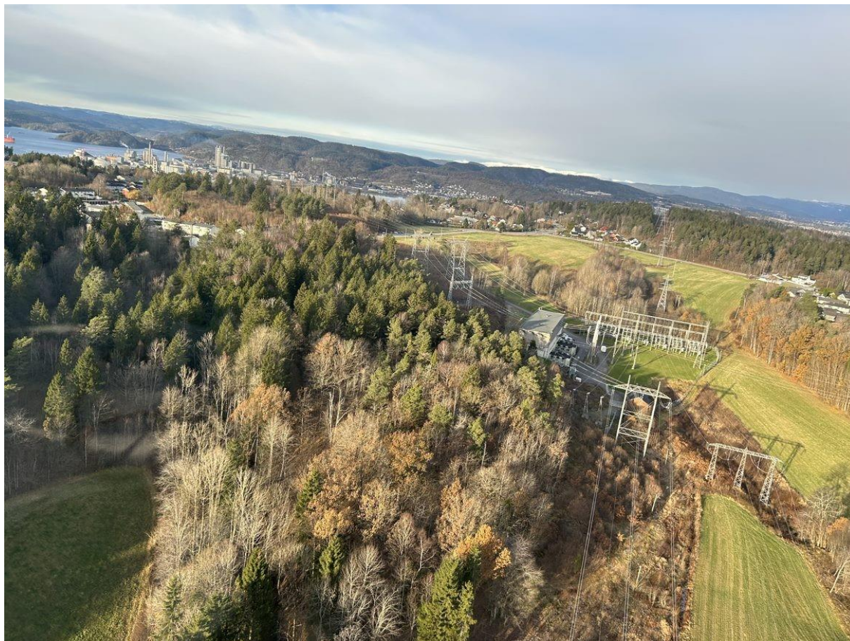
Figur 4 Eksisterende Porsgrunn transformatorstasjon. Skogen til venstre for stasjonen i bildet inngår som alternativ A for ny transformatorstasjon.
