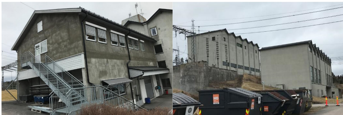
Figur 4 Eksisterende oppmøtebygg (øverst) og fasekompensatorbygg og kontrollhus skal rives.
