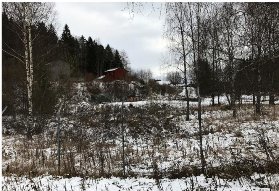
Figur 2 Området "Mudda" der terrenget skal heves og det bygges nytt kontrollhus. To av de gamle Statnettboligene som skal rives ses i bakgrunnen. På dette arealet bygges ny garasje/verksted.
