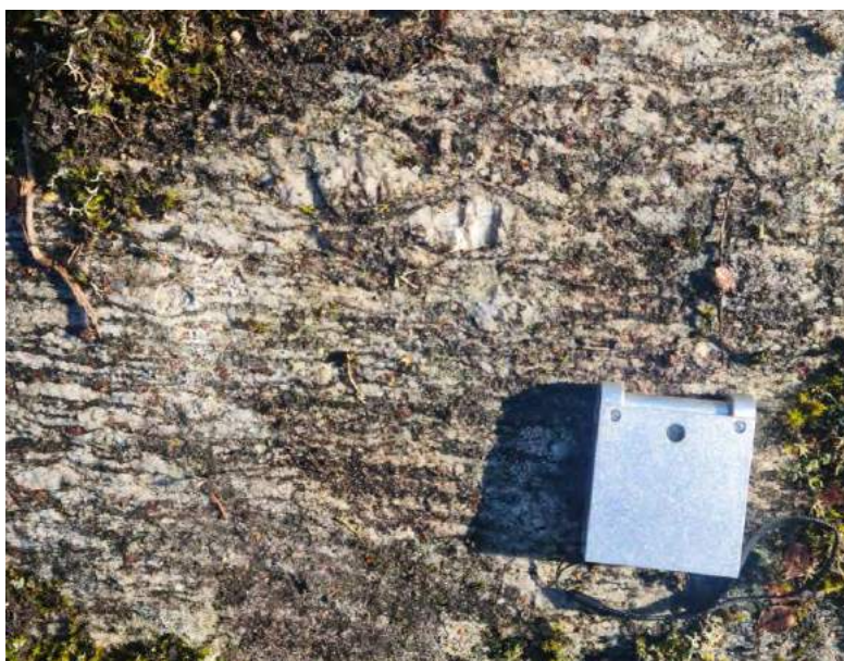
Figur 3-10: Detaljbilde av bergmassen. Bildet tatt ved befaring 23.03.2022.
