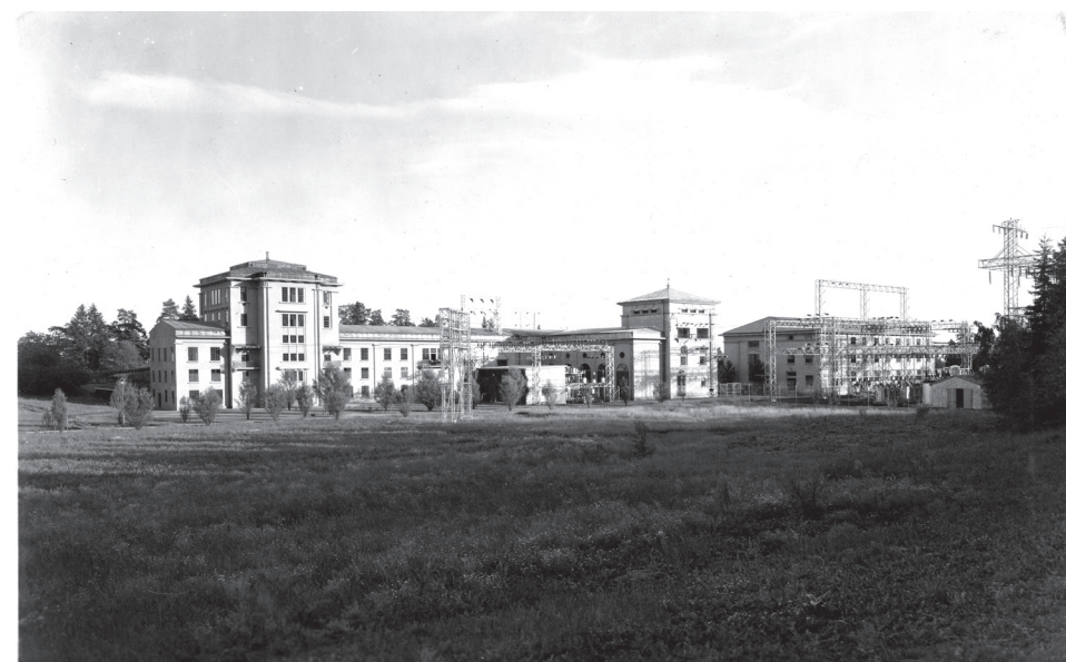
Gamle anlegg må fornyes. Her er Smestad transformatorstasjon fra 1922/28
