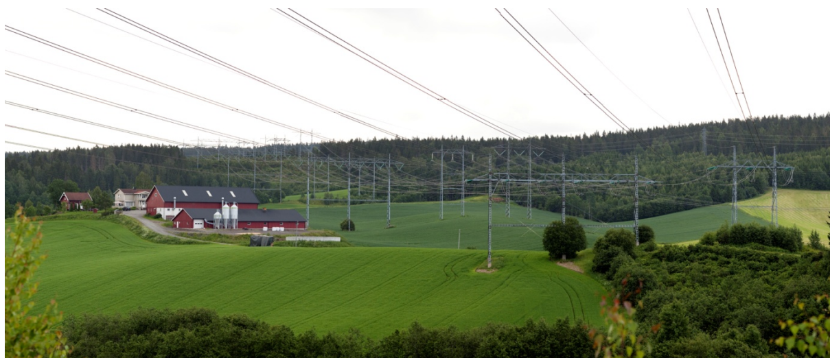
Figur 23 Fire sentralnettsledninger går parallelt et stykke i Sørums kommun. Kilde: Statnett
