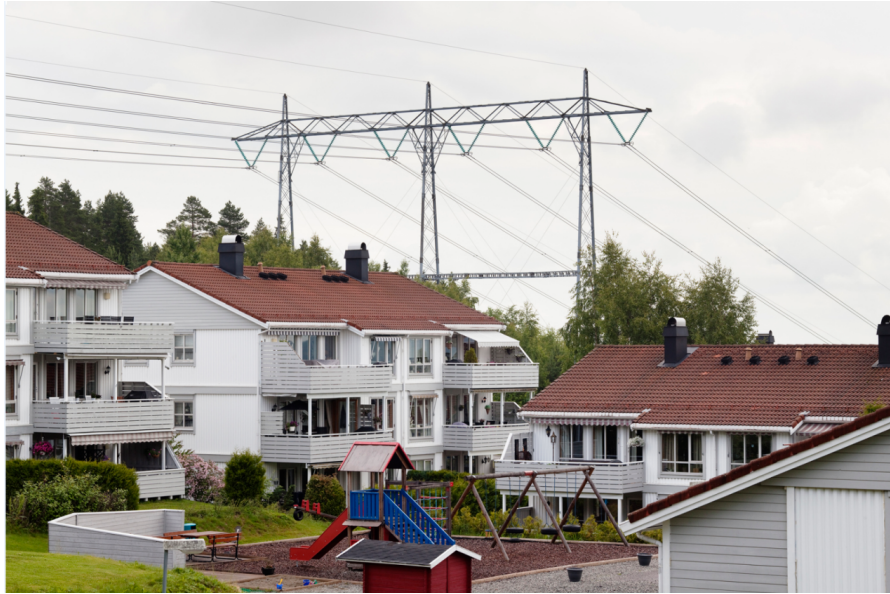
Figur 4 Boliger som er bygget i nærheten av kraftledning
