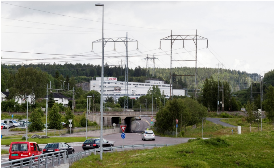
Figur 20 Bilde tatt nordvest i Lørenskog der det går flere sentralnettsledninger
