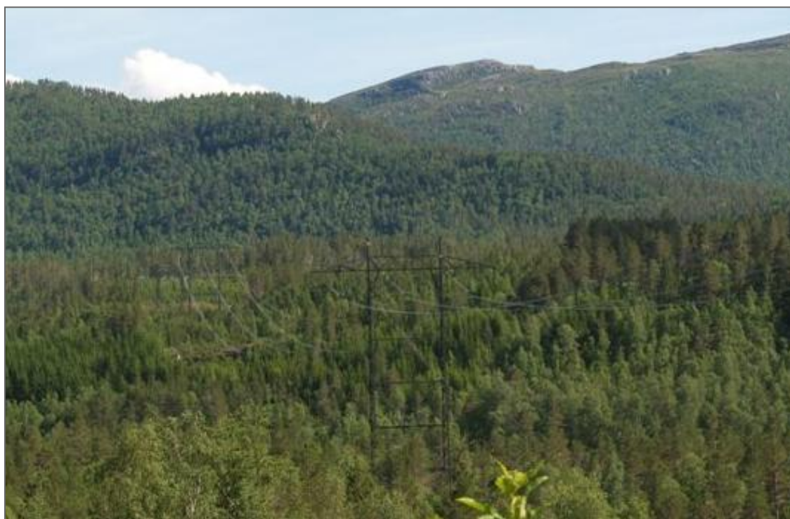
Figur 30. Eksempel på kamuflert kraftledning. Figuren viser en kraftledning med grønnmalte master, matte liner og komposittisolatorer for å redusere den visuelle virkningen i landskapet.
