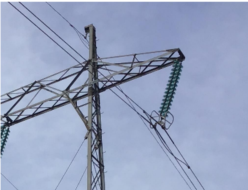
Figur 4-1. Antall skåler skal økes fra 14 til 17 noe som innebærer en senking av linja med 0,5 m. Kilde: Statnett.
