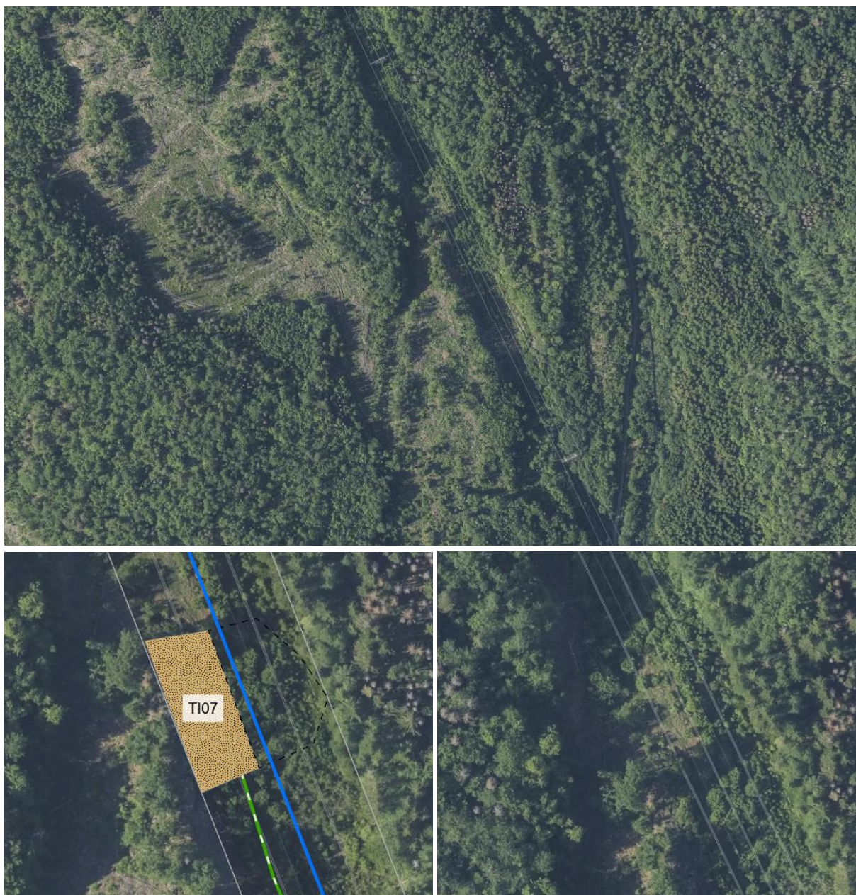
Figur 5-19 Oversiktsbilder/flyfoto over terrenget mellom mast 35 og 36 Hof-Tveiten.
