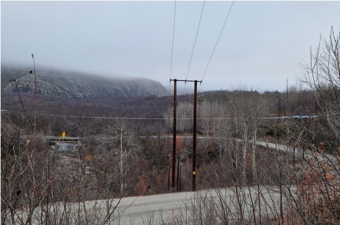
Figur 8-7: Nedre del av delområdet har stor inngrepsgrad, særlig her hvor sentralnett krysser distribusjonsnett sammen med kjørevei. (Kilde: COWI)
