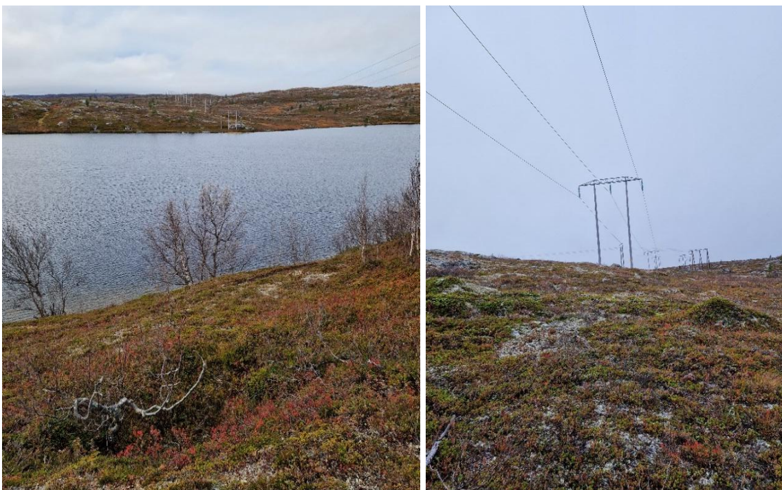
Figur 8-2: Bildet til venstre viser kraftledningene over Snarevatnet, bildet er tatt mot sørvest. Bildet til høyre viser mastene på nært hold ved krysningspunkt for sentralnett, sett mot øst. (Kilde: COWI)
