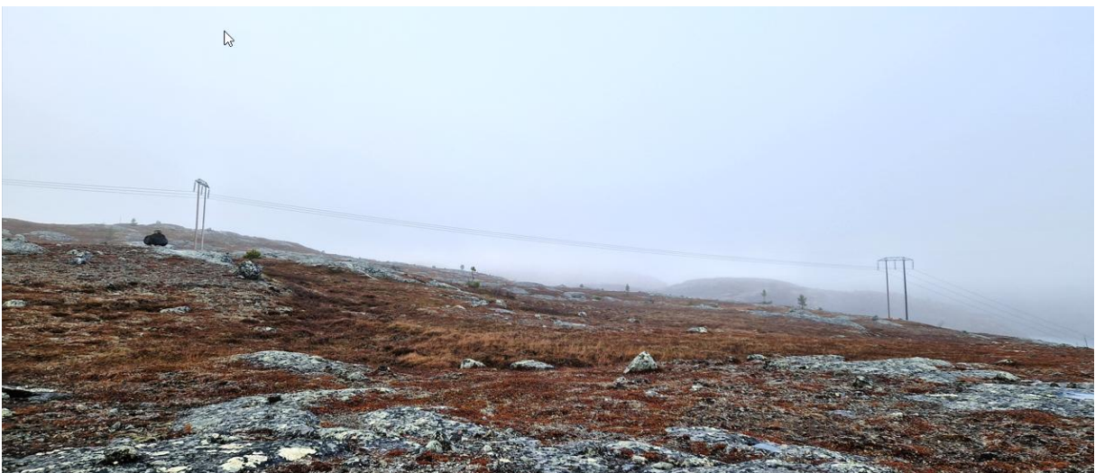
Figur 6-4: Bildet tatt mot nordvest og viser eksisterende master og linjer for traseen Kirkenes-Varangerbotn. (Kilde: COWI)
