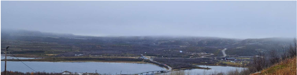
Figur 8-10: Friluftslivsområdet Sandneselvas utløp til venstre i bildet, til høyre i bildet ses vegen inn til tiltaket og dagens grustak der ny koblingsstasjon er planlagt. Nye ledninger er planlagt på fjellet til høyre i bildet. (Kilde: COWI)
