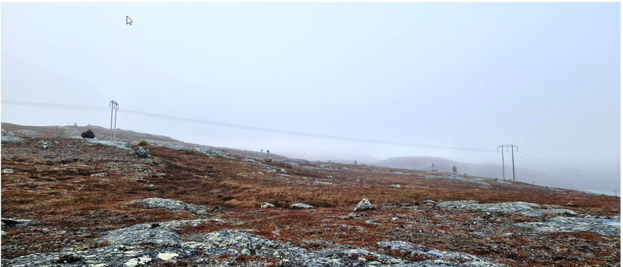
Figur 6-3: Bildet tatt mot nordvest. (Kilde: COWI)
