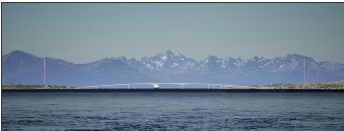
Figur 14 Visualisering av 120-130 meter høye master på hver side av Sortlandsundet med ledningstrekk og flymarkører sett mot sør.
