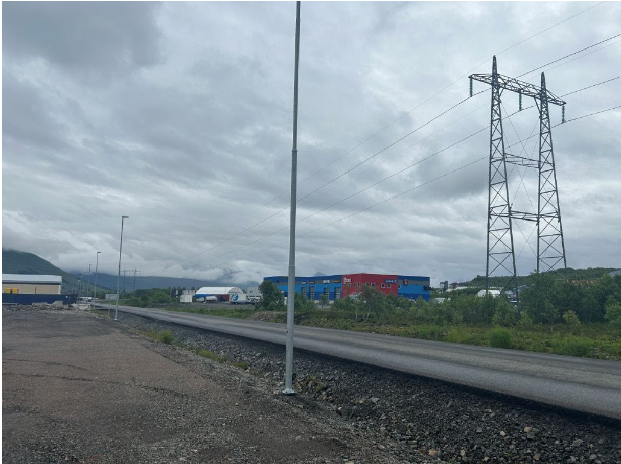
Figur 3 Eksisterende 132 kV forbindelse i næringsområde på Langøya. Denne forbindelsen søkes revet til fordel for ny 132 kV ny dublert forbindelse, hovedsakelig i kabel.
