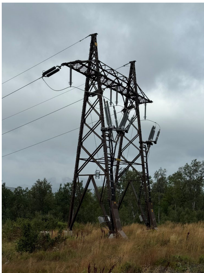
Figur 12 Bilde av aktuell kabelendemast fra Boltås stasjon.
