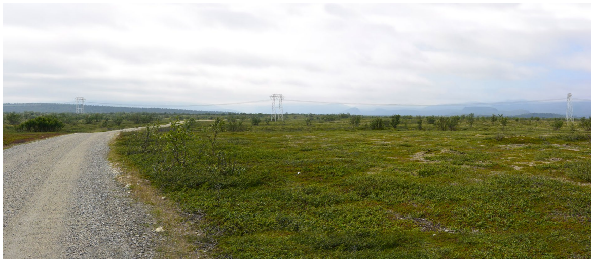
Figur 28: Fotomontasje som viser 420 kV master i samme mastepunkt som dagens 132 kV ledning. I fotomontasjen er ikke 66 kV ledningen med da denne er forutsatt revet.
