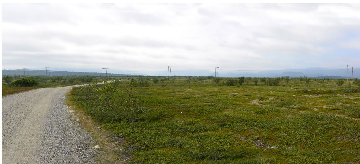
Figur 3: Foto som viser dagens situasjon med 132 kV ledning og 66 kV ledning. Foto er tatt langs vegen inn til nasjonalparken.
