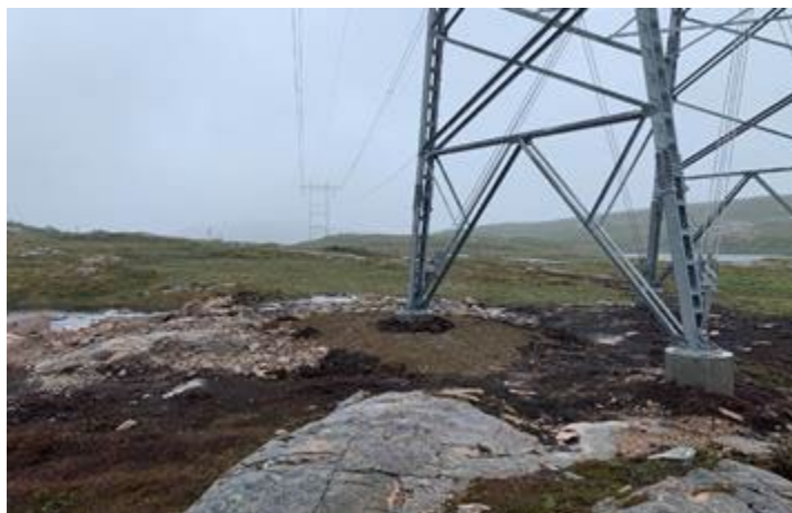
Figur 14: Eksempel på mast som står på fjellfundament (Statnetts håndbok i terrengbehandling)
