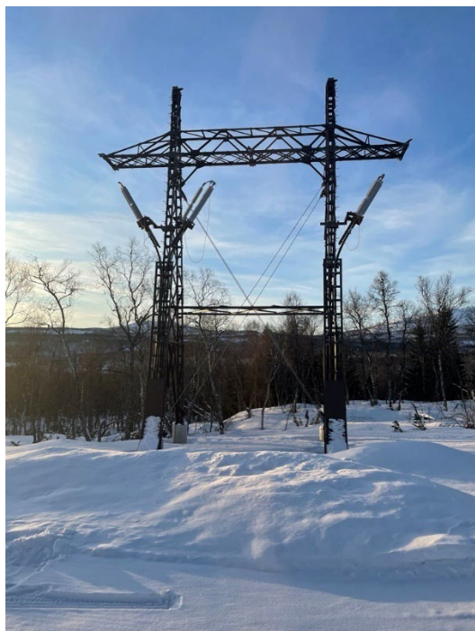
Figur 11: Eksempel på kabelendemast for 132 kV kabel.
