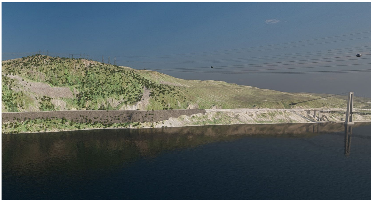
Figur 7. Illustrasjon fra Kvalsundet hvor det vil være luftfartsmerking av ledningen.
