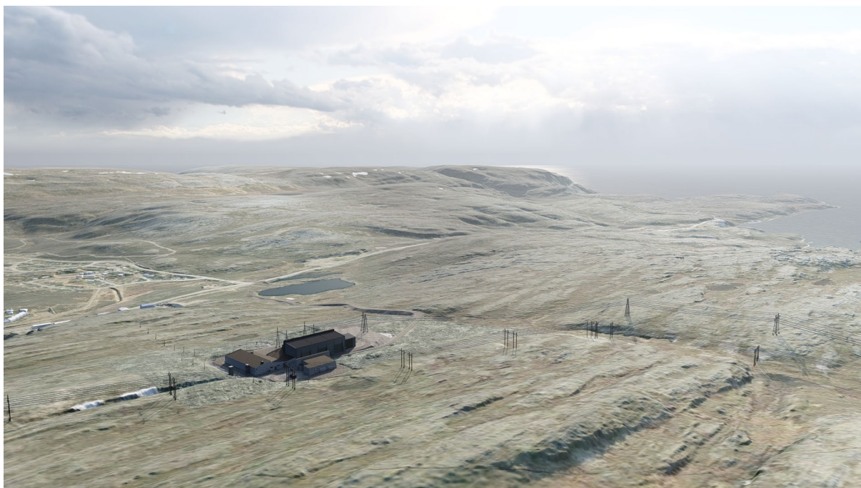
Figur 3. Ledningsinnføring mot Hyggevatn transformatorstasjon.
