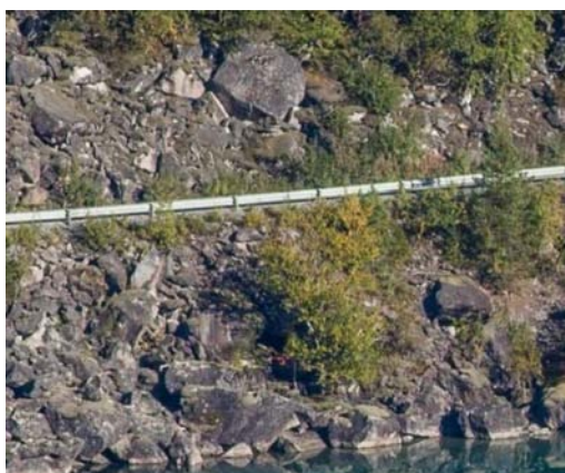
Figur 1.4: Detalj av skredutsatt veg til Salten transformatorstasjon av NGI
