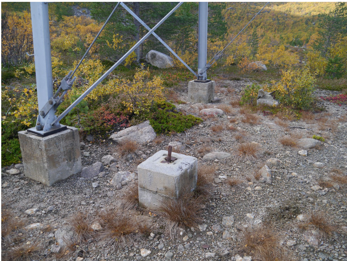
Figur 4.3-2 Mast 175 på Tjeldøya er en av tre master som har blitt skiftet til en kraftigere type (275 kV) etter havari for å kunne tåle belastningen fra vind, is og snø. De opprinnelige prefabrickerte fundamentblokkene (nærmest i bildet) er forlatt til fordel for plass-støpte (til venstre).
