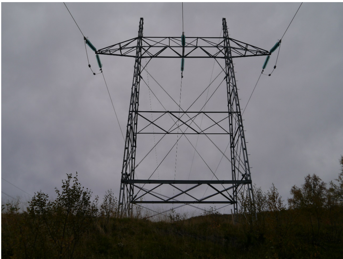
Figur 4.2-6 Mast 232, en av de seks forankringsmastene som ikke er vinkelforankringsmaster.
