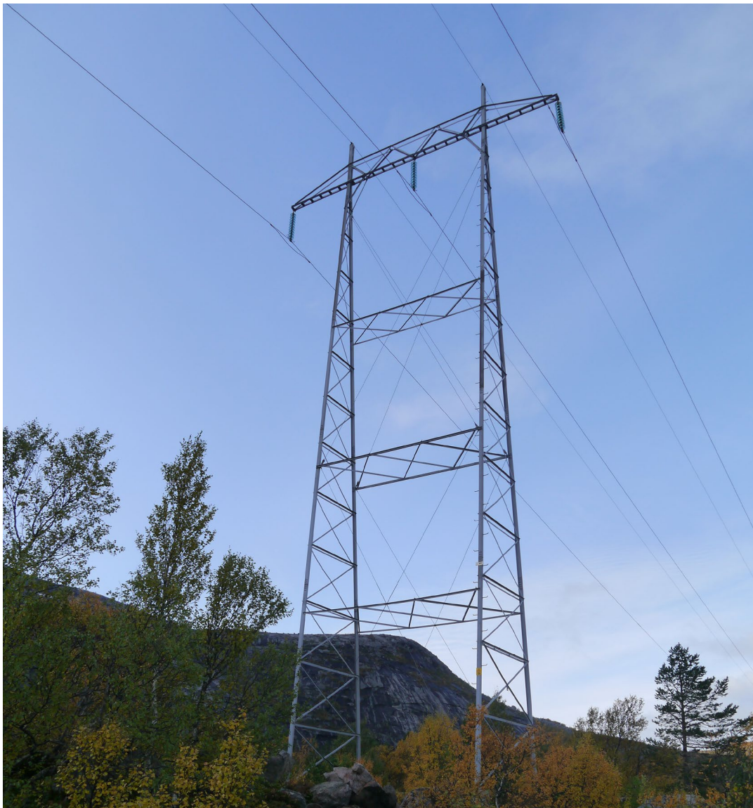
Figur 1.3-1 Bæremast på Tjeldøya. 188 av de 233 mastene på ledningen er av denne typen.
