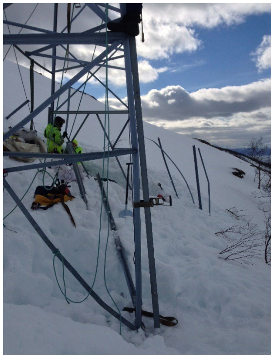
Figur 5-4 og 5-5 Skadeutbedring etter snøsig ved Krokvatnet. På bildet til høyre er en K-forgitring nærmest ferdig montert. Noen av de utskiftede/skadede jernene står i snøen. Den nærmeste vangen har blitt bøyd, så det er gjort klart for å forsterke denne med et ekstra kanaljern/U-bjelke. Nærmest i bildet er det også jern som er skadet, disse har blitt bygd om til K. (Kilde: Statnett)
