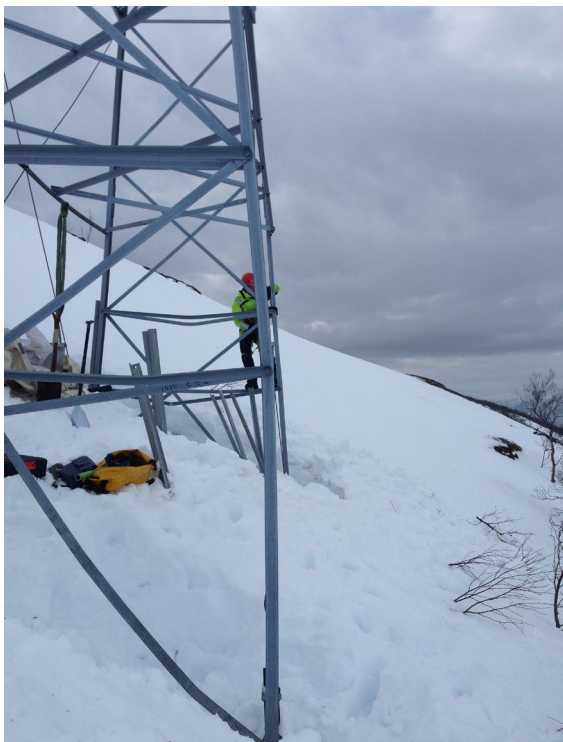
Figur 5-4 og 5-5 Skadeutbedring etter snøsig ved Krokvatnet. På bildet til høyre er en K-forgitring nærmest ferdig montert. Noen av de utskiftede/skadede jernene står i snøen. Den nærmeste vangen har blitt bøyd, så det er gjort klart for å forsterke denne med et ekstra kanaljern/U-bjelke. Nærmest i bildet er det også jern som er skadet, disse har blitt bygd om til K. (Kilde: Statnett)
