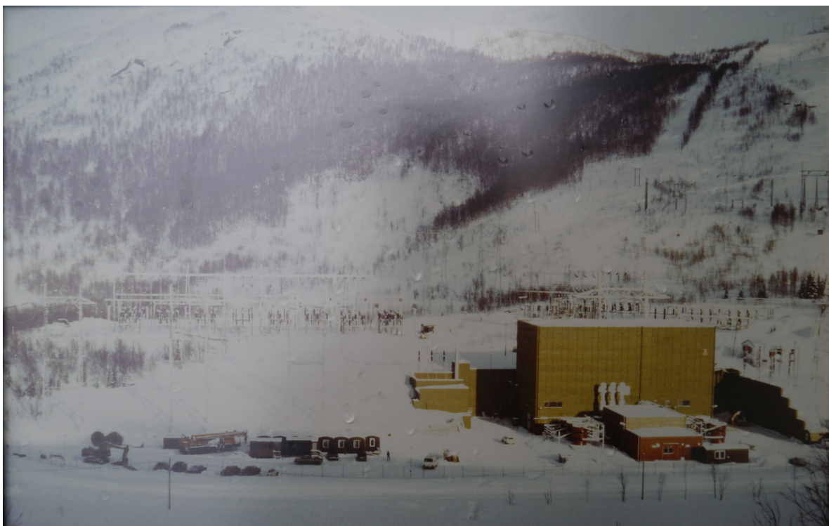
Figur 3.1-1 Kvandal koblingsstasjon sett fra sørøst i 1982. Ny transformatorstasjon var blitt etablert i forbindelse med at 420 kV-ledningen nordover fra Ofoten ble lagt via Kvandal.
