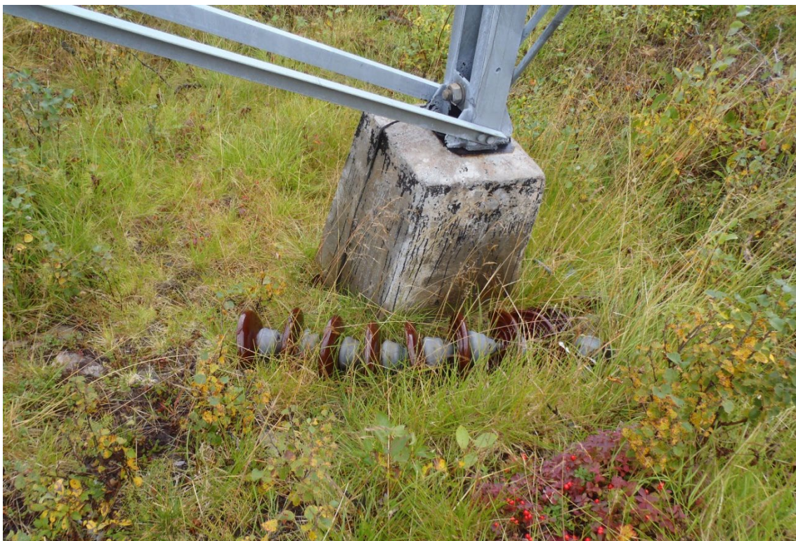
Figur 4.3-3 Prefabrikkert fundamentblokk og avdanket hengekjede med porselensisolator. Mastebeinet med doble U-profiler er typiske for forankringsmaster. (Kilde: Statnett)
