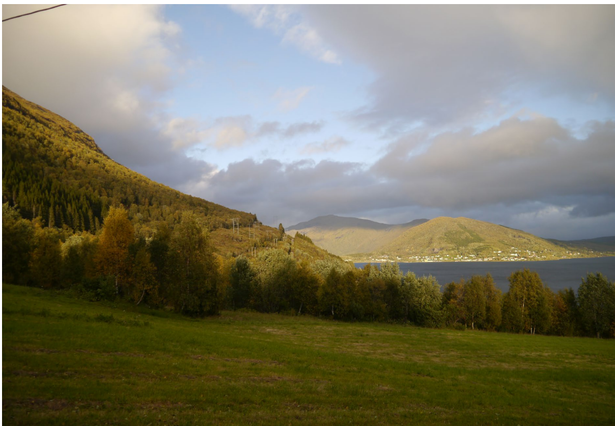
Figur 4-2 Parti av ledningen ved Dragvika. 132 kV Kvandal-Kvitnes og de to 66kV-ledningene Evensmark-Niingen skifter retning her.
