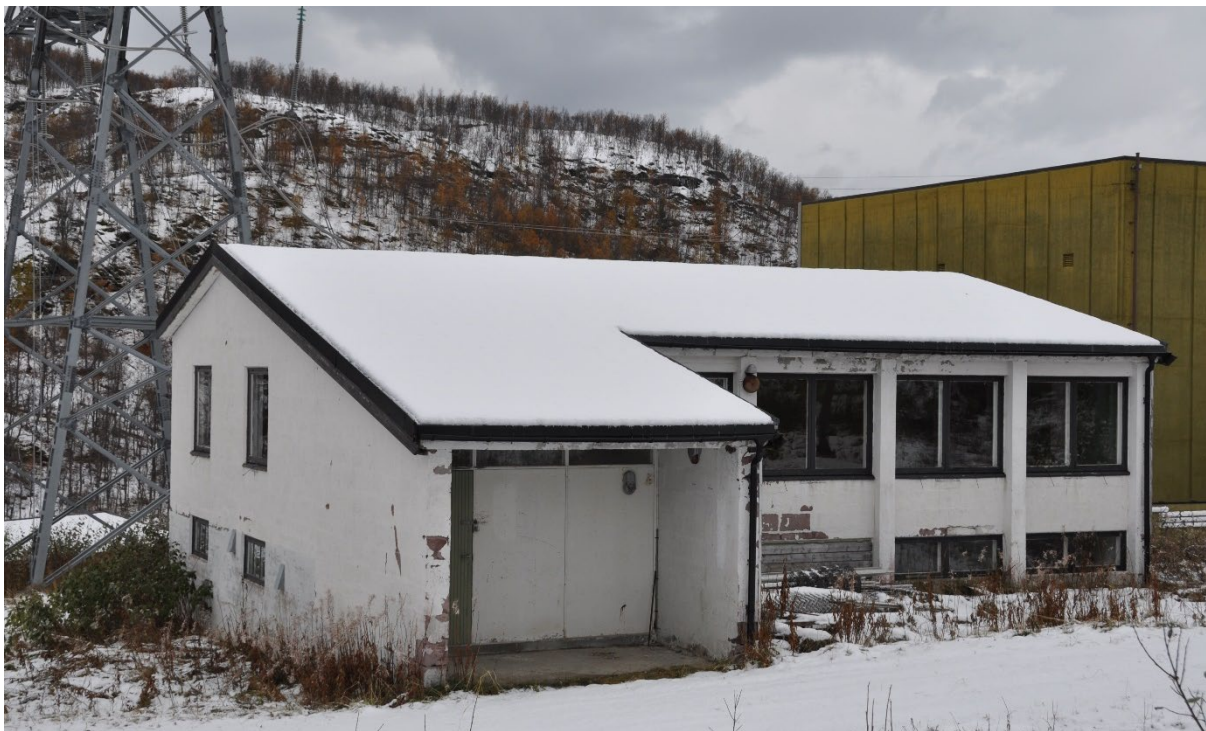
Figur 4.5-2 Koblingsstasjonen i Kvandal før riving i 2014 (Kilde: NVE)
