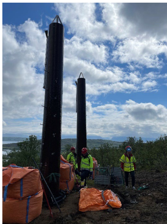
Figur 26 Bygging av komposittmast. Hallingmast utviklet en "hatt" for å bruke på elementene, slik at det ble enklere å koble dem sammen.
