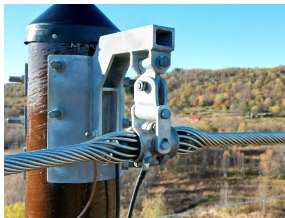
Figur 29 Oppheng OPGW (toppline) på kompositt-mast.
