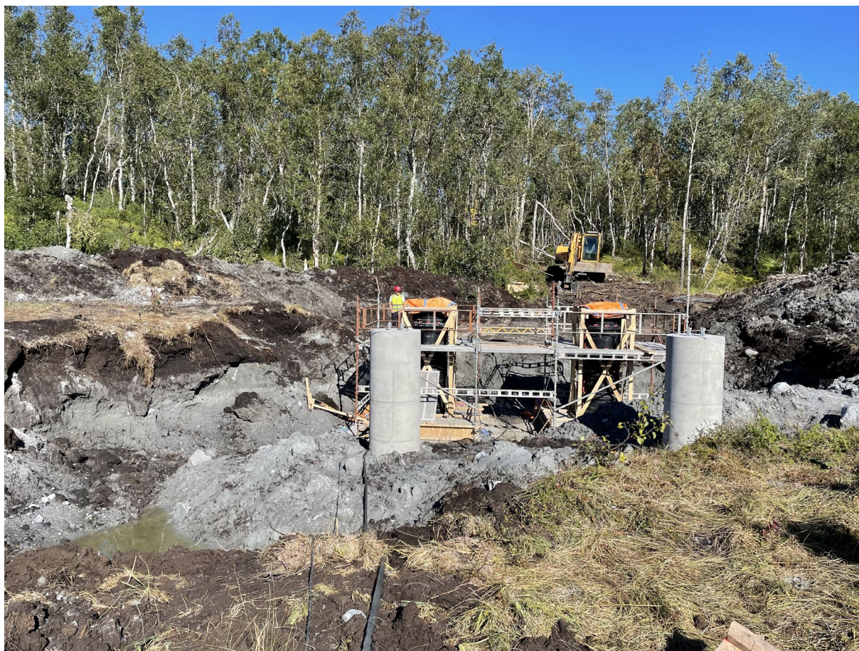
Figur 15 Typisk arbeid med vanlig jordfundament for stålmaster (mast 130).
