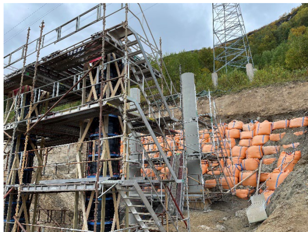
Figur 13 og 14 Mast 87 ved Bogen viser noen av utfordringene man kan støte på. Sterkt skrånende terreng, med behov for å unngå utgliding, krevde at entreprenøren var kreativ.
