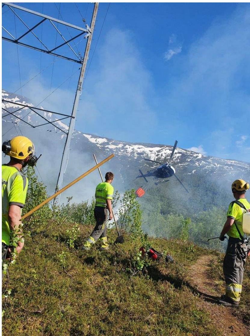
Figur 38 Slokkearbeider etter at gnister satte fyr på lyng ved mast 70. Entreprenørens risikovurdering og tiltak ved hendelse fungerte godt.
