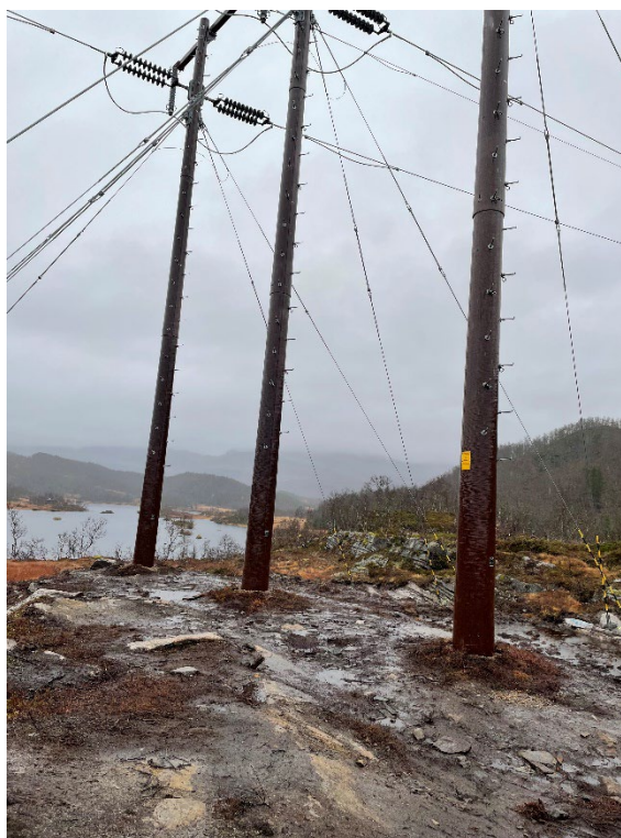
Figur 17 Fundament for en forankringsmast av kompositt skaper lite sår i grunnen.
