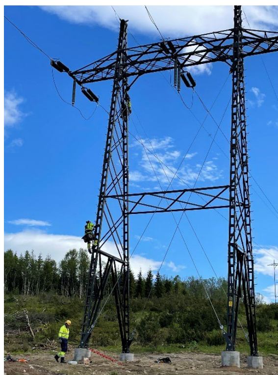
Figur 24 Typisk bygging av stålmaster (her kamuflert).
