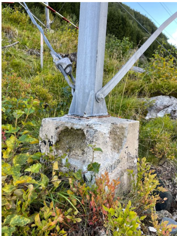
Figur 11 Gammelt, forvitret fundament.
