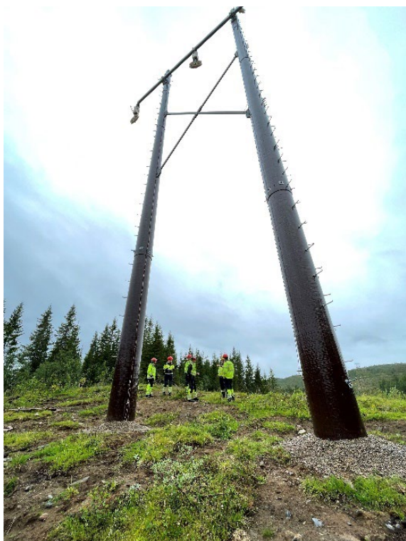
Figur 25 Typisk bygging av komposittmast.
