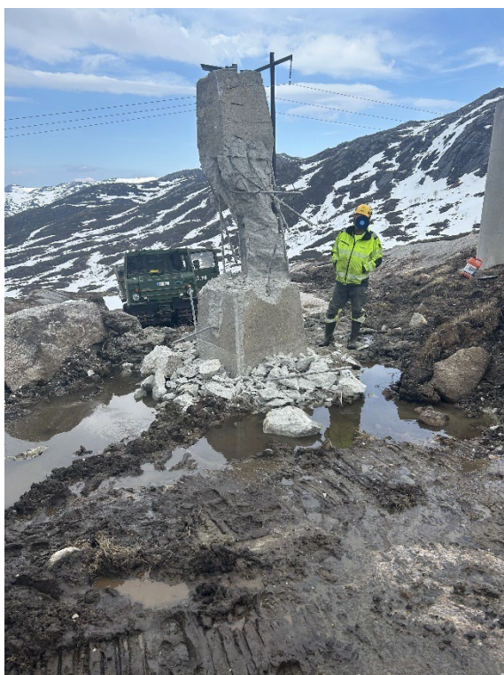
Figur 8 Mastefundamenter ble pigget som et moment i saneringen i Laksåmarka.
