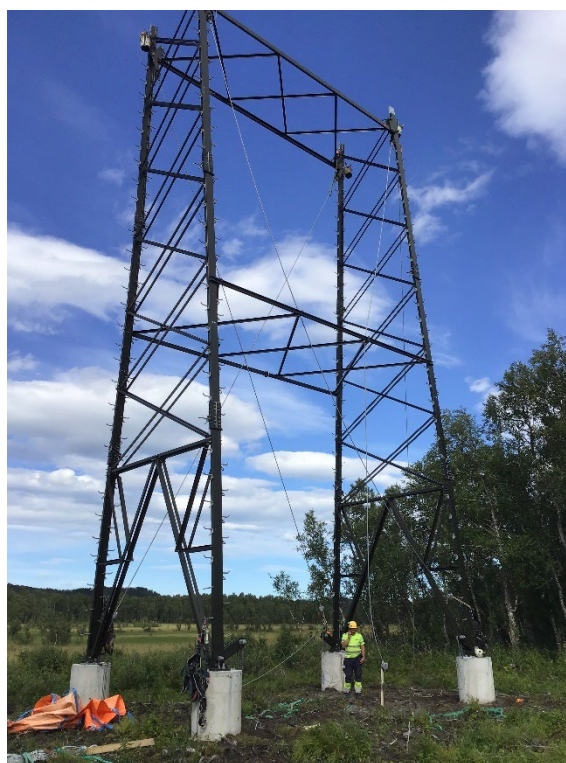
Figur 19 Montering av den nye stålmaster i naturreservatet.
