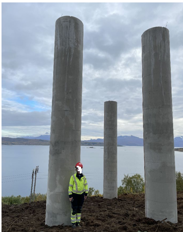
Figur 16 Mastene i Bogen ble erstattet med forsterkede fundament for å motstå ras.
