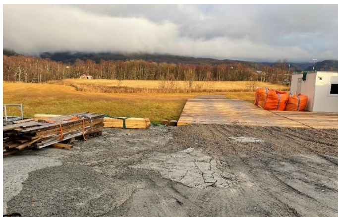
Figur 3 Eksempel på anleggsplass med lite arealbruk, her ved Bjerkvik. Bruk av stokkmatter der det kjøres, noe grus direkte på marka og ellers lagring direkte på marka.
