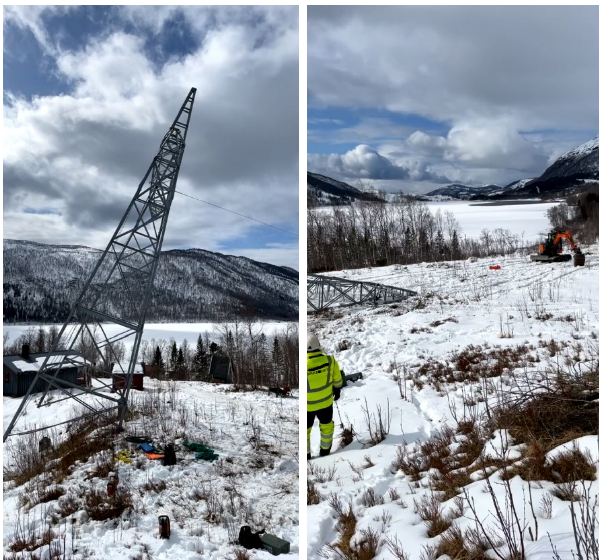
Figur 4a og 4b Velting av mast med gravemaskin ved Boltås.
