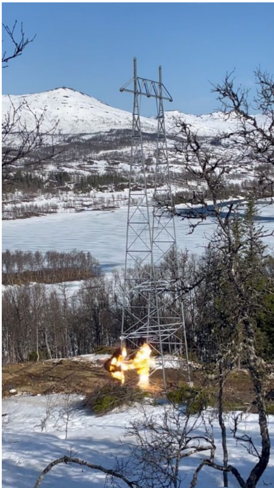
Figur 5 Velting av mast ved sprengning av mastestål med detonerende lunte på Boltås.
