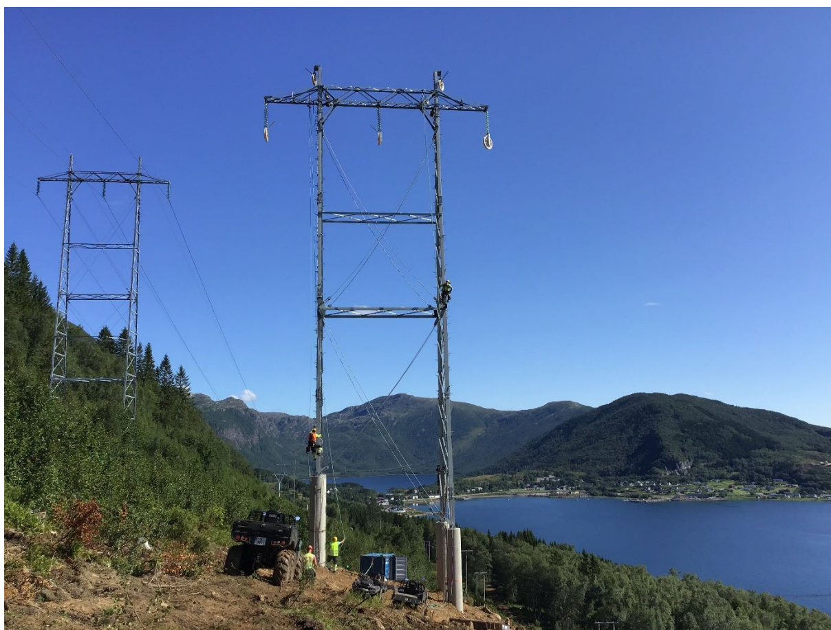
Figur 27 Stålmastmontering på rasfundament. Bæremast 90 ved Bogen.
