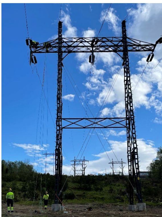
Figur 23 Typisk bygging av stålmaster (her kamuflert).
