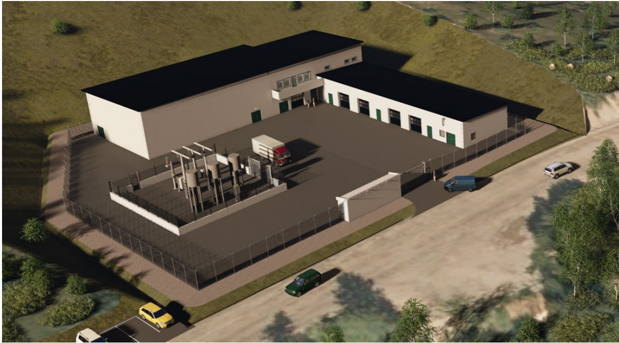
Figur 5-7 Stasjonsbygning, lager og sjakt for luftisolert anlegg
