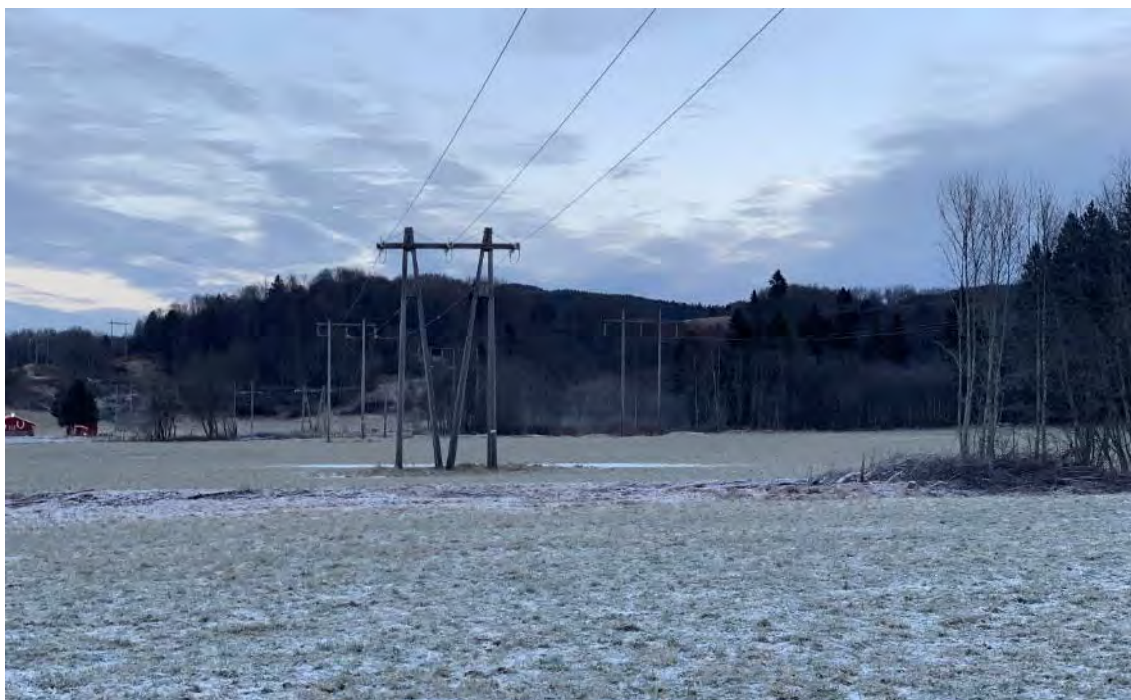
Figur 7 Eksisterende master eid av Tensio TS, Elkem og Nettselskapet må rives for å kunne bygge stasjonsområdet.
