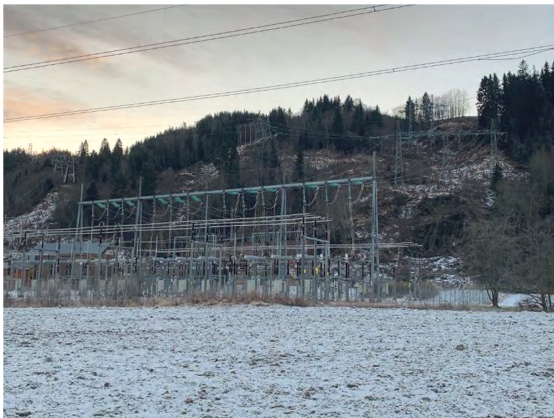
Figur 8 Dagens 300 kV apparatanlegg og samlemast skal rives.
