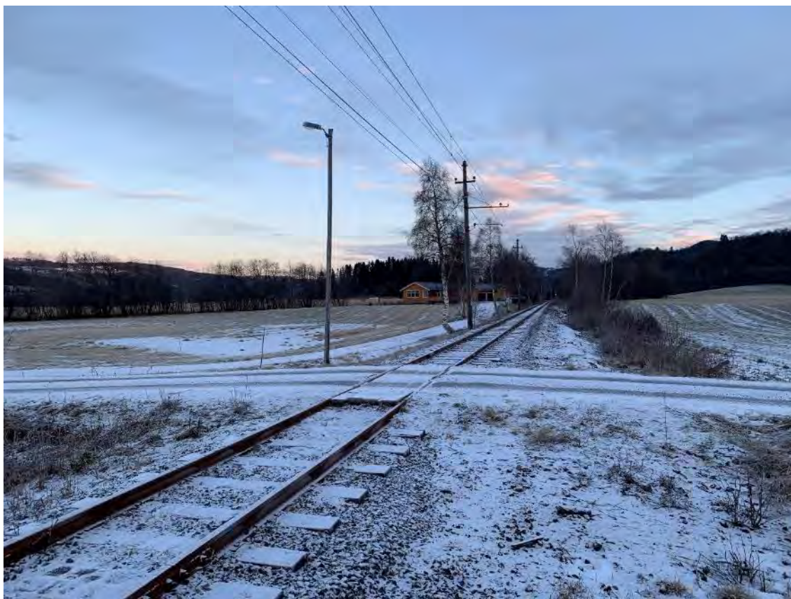
Figur 11 Planovergang og kjøreledning for Thamshavnbanen der den krysser Prestmovegen.
