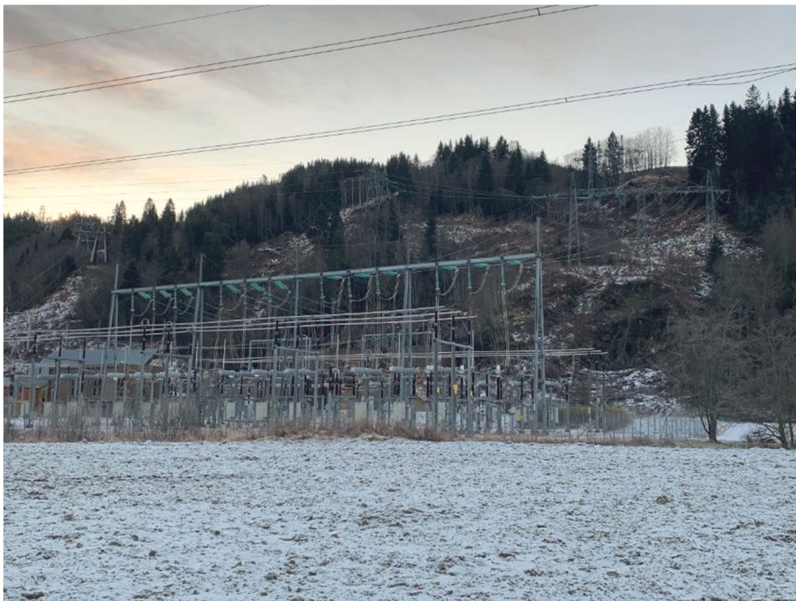
Figur 8 Dagens 300 kV apparatanlegg og samlemast skal rives.
