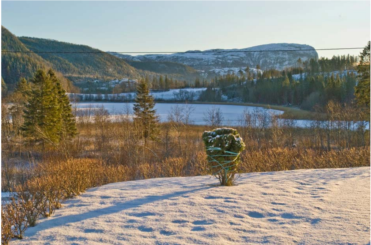
Figur 12 Strekningen langs Åsmundvatnet med sanert 66 kV-leding og kablet 132 kV-ledning. Visualisering: Einar Berg
