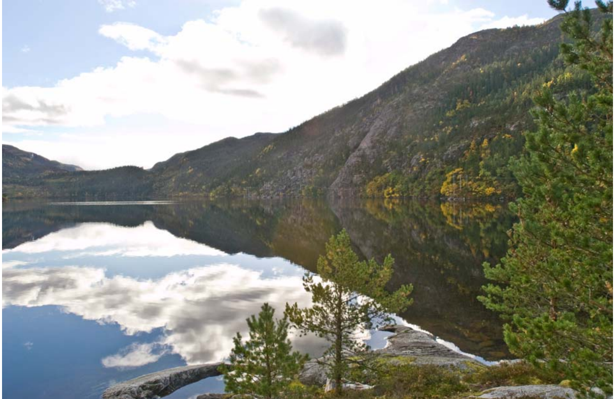
Figur 7 Dagens situasjon med 66 kV-ledning i strandkanten langs Mørrivatnet sett fra "Blåbærlyngen". Ny 132 kV-ledning vil gå i samme trasé i alternativ A. Foto: Einar Berg
