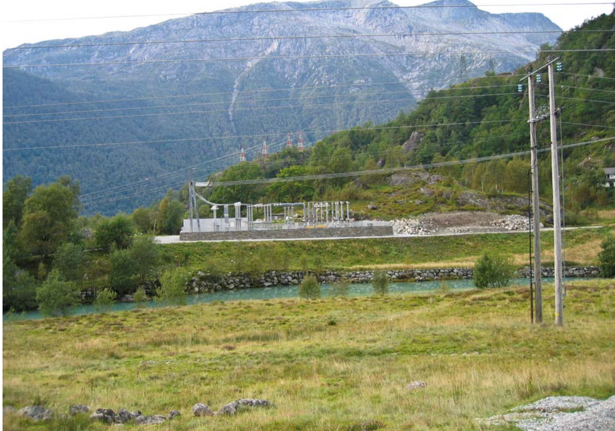
Figur 34 Blåfalli-Vik koblingsanlegg. Anlegget er rammet inn med tørrmur og sprinkelgjerde i stedet for tradisjonelt flettverksgjerde. Derved blir mye av rotet på bakkeplan skjult for innsyn. Foto: Jan Ove Sæd
