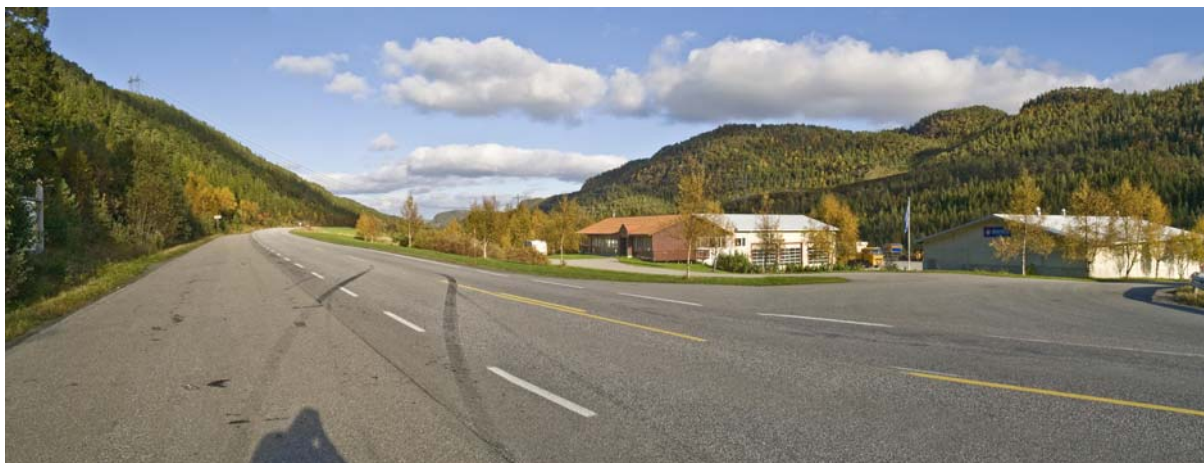
Figur 24 Fra vegstasjonen i Norddalen. Alternativ 1.0 krysser over dalen omtrent midtveis bak i bildet. I alternativ 1.2 vil kryssingen skje nokså fjernt i bakgrunnen sett herfra. Foto: Einar Berg
