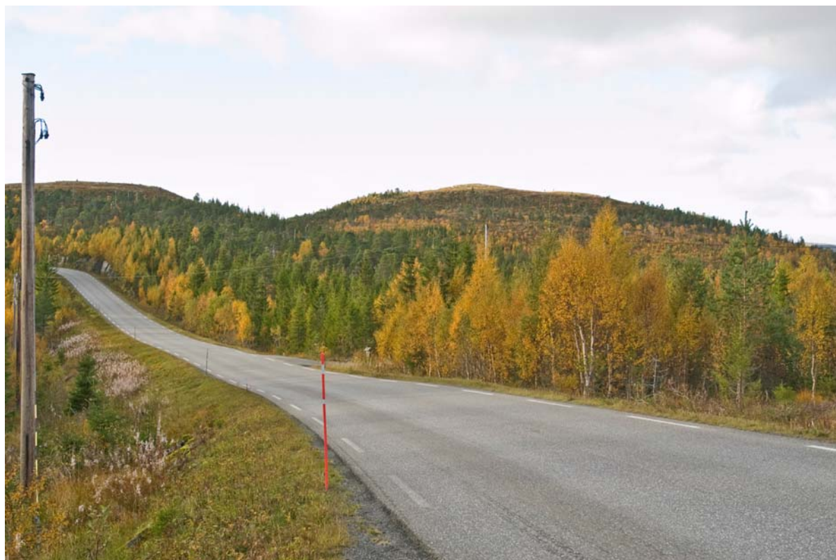
Figur 18 I dette området mellom Lonin og Skihytta vil ny 420 kV-ledning krysse over riksveien inn mot Roan transformatorstasjon i Alt. 1.0. Foto: Einar Berg
