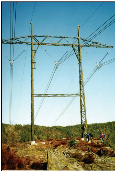
Figur 5: Kamouflerende tiltak. Bildet viser en mast som er farget mørk olivengrønn/brun for å gjøre den mindre synlig der den sees med bakgrunn i vegetasjon eller mørkere partier i landskapet. Her er det også benyttet isolatorer i kompositt i stedet for av glass, og linene er farget.
