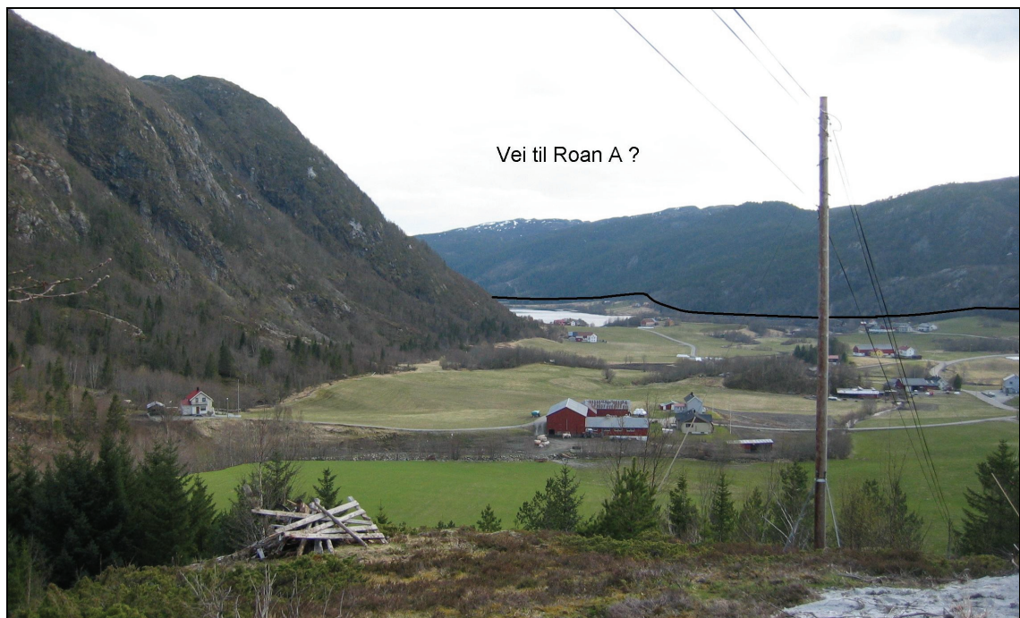
Figur 20: Straum og Straumsvatnet i Roan sett fra nordøst. Roan transformatorstasjon alt. A er tenkt plassert sør for Straumsvatnet. Det må bygges en ny vei inn til stasjonen i lia øst for vatnet. Pga svært dårlige grunnforhold må ny vei legge litt opp i lia på motsatt side av vannet.
