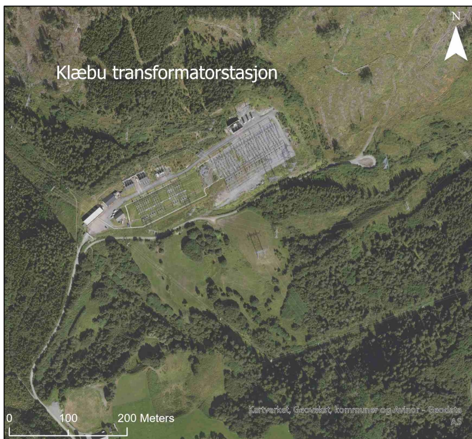
Figur 4-2. Flyfoto over Klæbu Transformatorstasjon.
