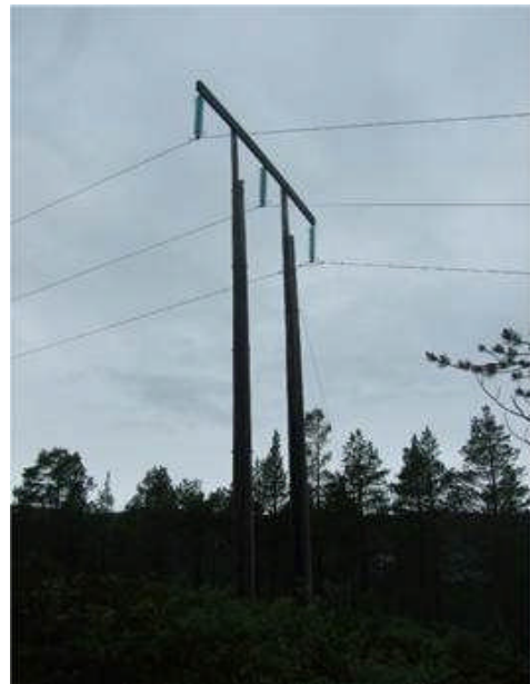
Figur 6. Eksempel på master benyttet på eksisterende 132 kV Snillfjord-Orkdal. Mast med kryssavstivning til venstre.
