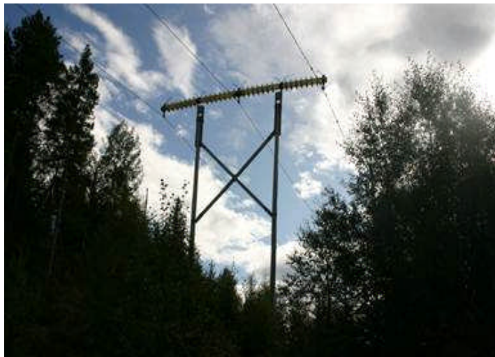
Figur 6. Eksempel på master benyttet på eksisterende 132 kV Snillfjord-Orkdal. Mast med kryssavstivning til venstre.
