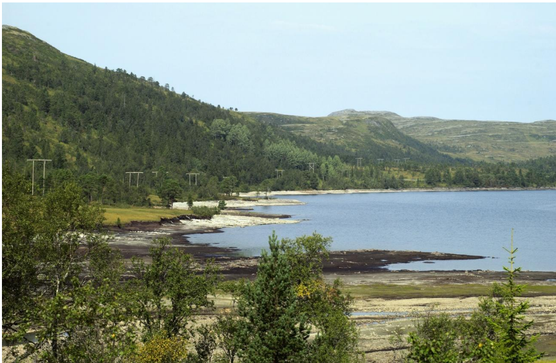
Figur 3. Våvatnet. 132 kV-ledningen går i strandsonen.
