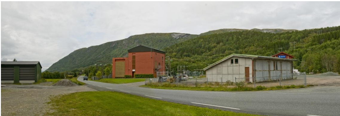
Figur 13: Regionalnettstasjonen i Snillfjord ligger ved innkjøringen til Krokstadøra østfra. Foto:
