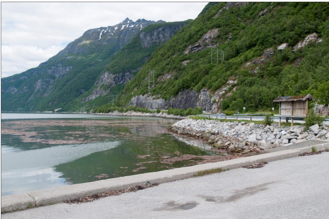
Figur 7: Ledningen er et markant innslag langs Sunndalsfjorden. Foto: Einar Berg.
