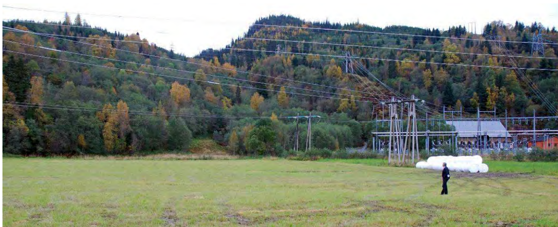
Figur 53. Område for utvidelse av Blåsmo transformatorstasjon.
