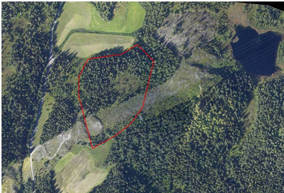
Figur 57. Område for Orkdal Vest a transformatorstasjon.
