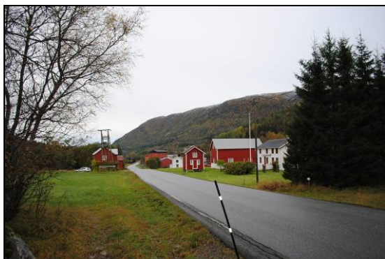
Figur 76 Tun nær Snillfjord trafo. Foto: NIKU.
