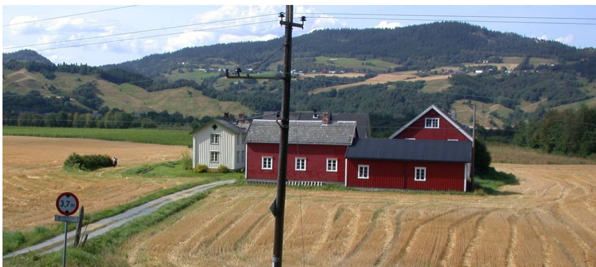
Figur 54 Firkanttun nært Orkdal transformatorstasjon. Foto: NIKU
