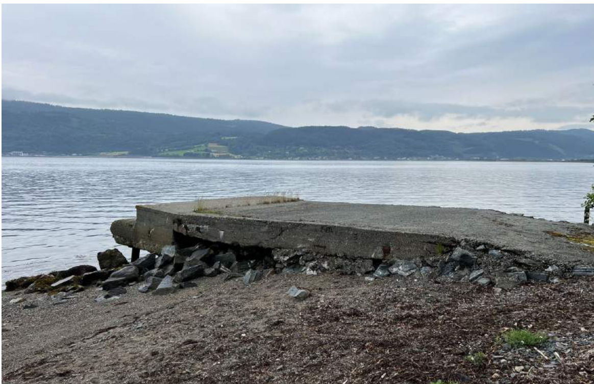
Figur 7: Eksisterende lossehakk ved "Surna kai".
