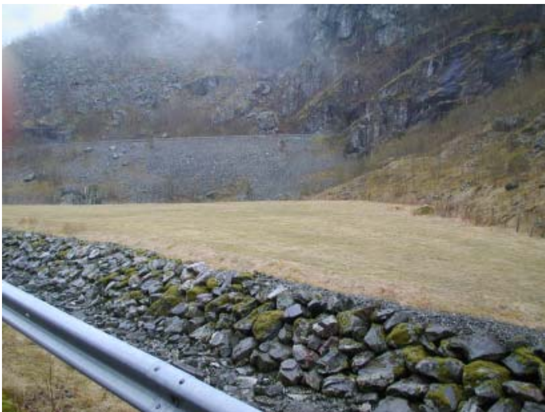
Figur 1. Kablene føres i ytterkant av jordet på bildet og opp skråningen mot Hylstunnelen (foto: Oddbjørn Skjævesland).
