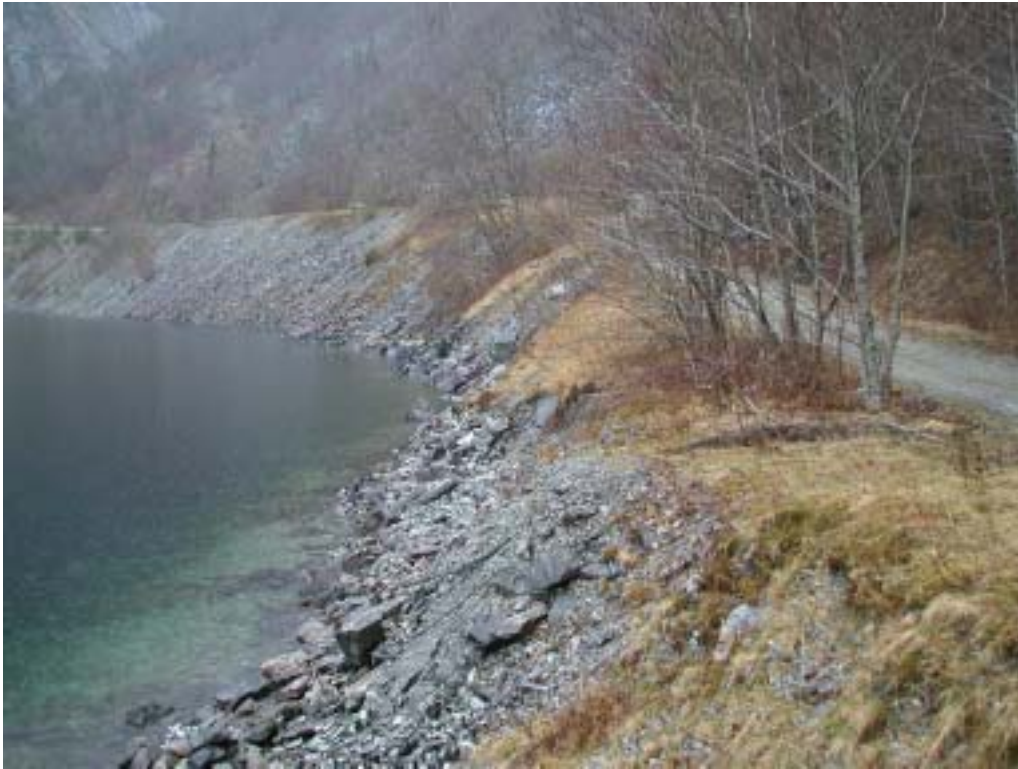
Figur 2. Kablene følger adkomstveien ned mot inntaket til Hylen kraftstasjon (foto: Oddbjørn Skjævesland).
