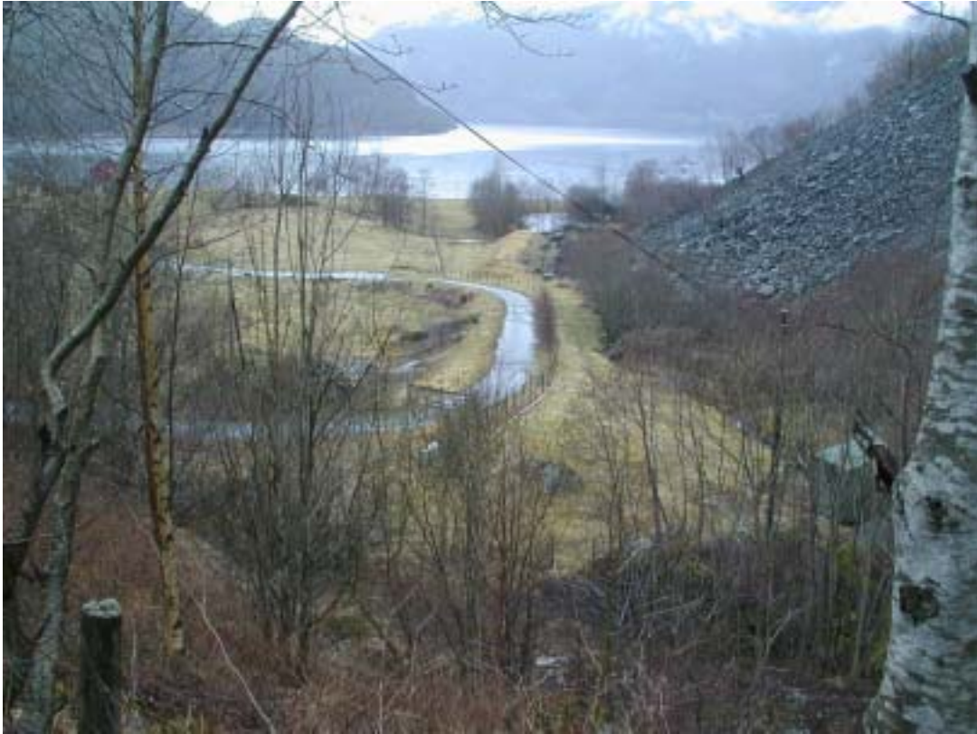
Figur 4. Kablene går over dyrket mark opp til veien inn mot Kvilldal kraftstasjon. Bildet er tatt opp ved veien inn til stasjonen (foto: Oddbjørn Skjævesland).
