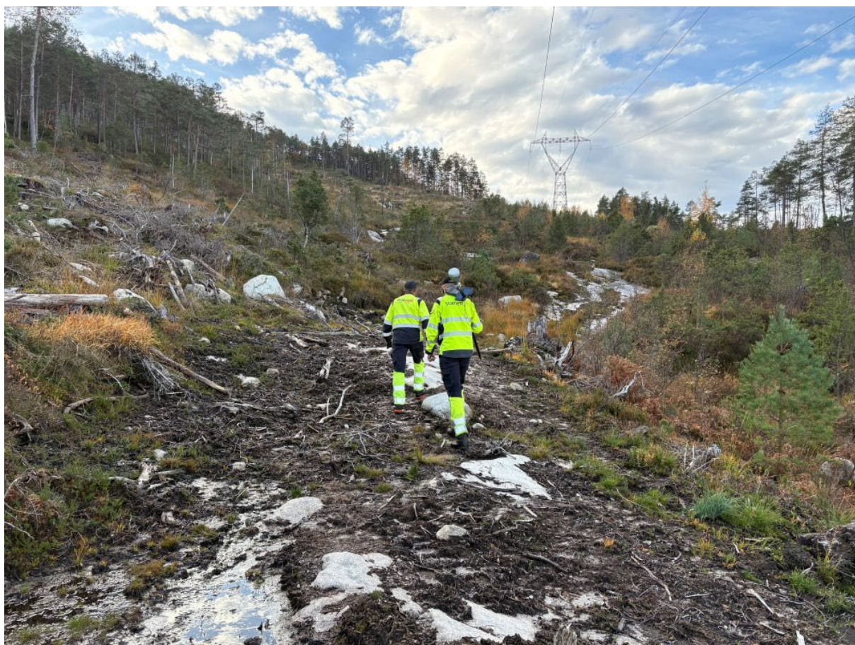
Figur 9 Statnett planlegger en permanent vei fra Tonstad koblingsstasjon til omsøkt mast 10. Veien søkes etablert over en tidligere kjøretrasé fra skogbruket.
