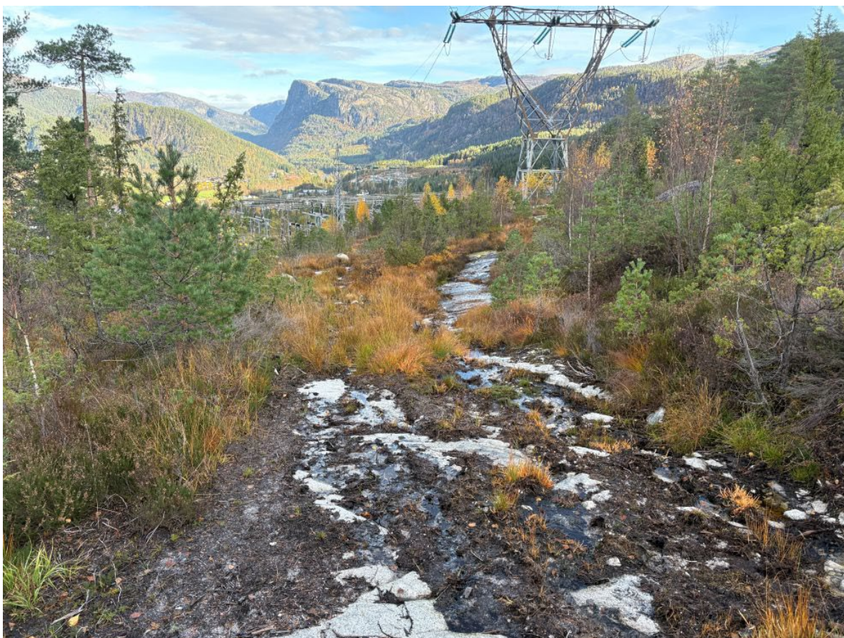
Figur 36 Omsøkt permanent vei fra Tonstad koblingsstasjon til mastepunkt 10 planlegges over tidligere benyttet kjøretrasé for skogbruket. Tonstad koblingsstasjon skimtes på bildet.
