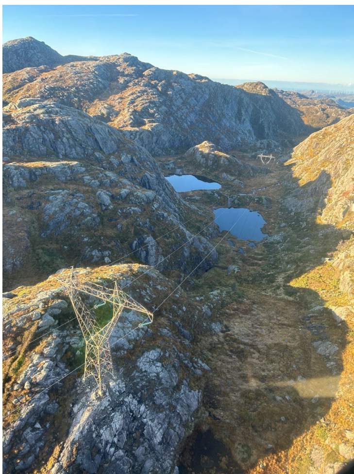
Figur 21 Statnett har justert trasé for ny 420 kV forbindelse til å følge eksisterende 300 kV lavere i terrenget enn tidligere vurdert løsning i høyden.
