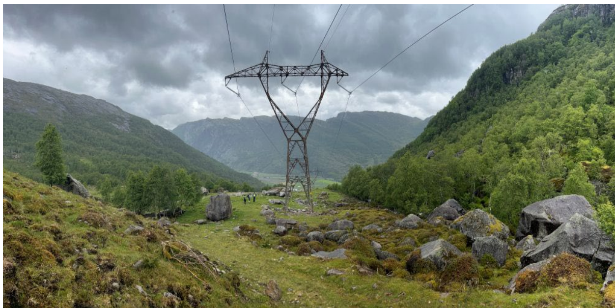
Figur 12 Eksisterende 300 kV forbindelse er bygget på 1970-tallet. Bildet er fra Ørsdalen i Bjerkreim kommune.
