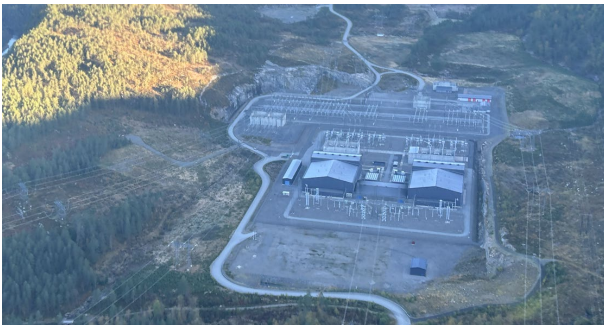
Figur 37 Ertsmyra transformatorstasjon i Sirdal sett fra sør mot nord. Planlagte tiltak ved transformatorstasjonen omfatter areal som er opparbeidet og som stort sett består av tidligere opparbeidet areal (inkludert massedeponi).
