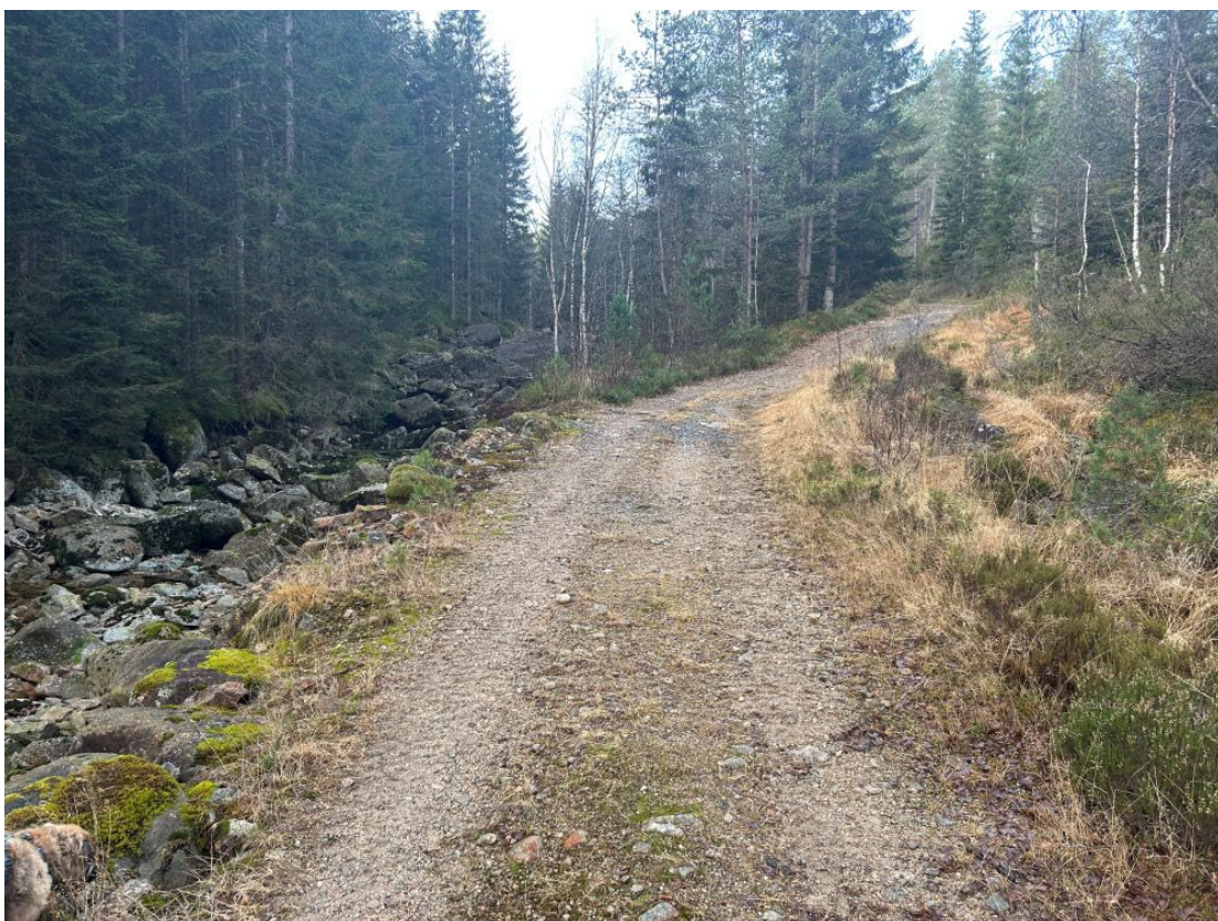
Figur 11 Statnett ønsker å benytte eksisterende vei fra Viraksveien til Lindvatnet i Sirdal kommune til transport av utstyr. Veien ligger inne i Øykjeheia naturreservat. Angitt som R11 i vedlegg 1 og i tabell i vedlegg 2.
