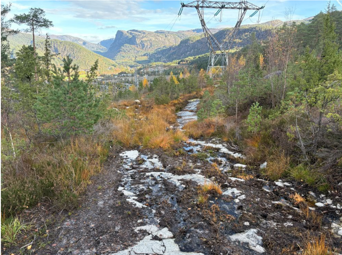
Figur 33 Omsøkt permanent vei fra Tonstad koblingsstasjon til mastepunkt 10 planlegges over tidligere benyttet kjøretrasé for skogbruket. Tonstad koblingsstasjon skimtes på bildet.
