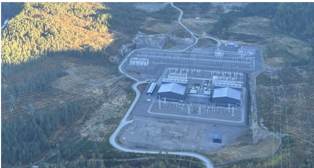
Figur 34 Ertsmyra transformatorstasjon i Sirdal sett fra sør mot nord. Planlagte tiltak ved transformatorstasjonen omfatter areal som er opparbeidet og som stort sett består av tidligere opparbeidet areal (inkludert massedeponi).
