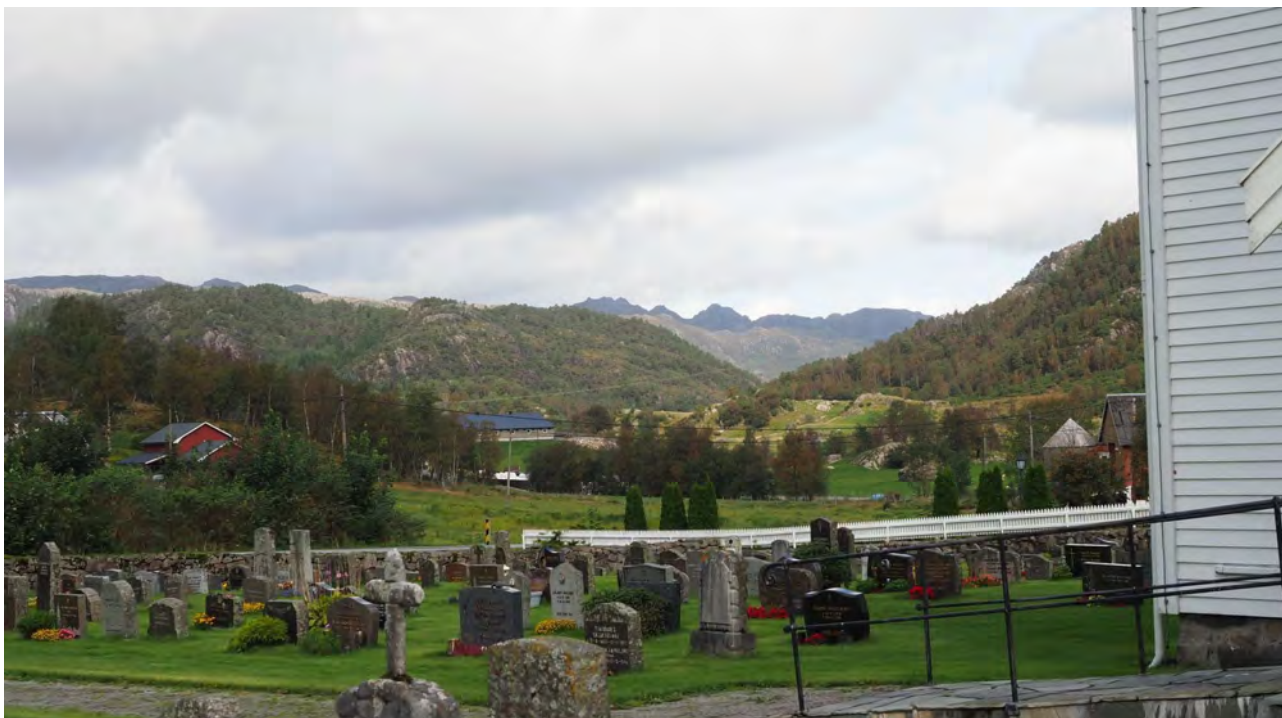
Figur 5-52: Tettstedet Ivesdal ligger nord for Hofreistæ og er sentrert rundt Ivesdal kirke. Mot nord er det et flatt jordbruksområde som strekker seg mot Birkelandsvatnet. Her krysser eksisterende og ny kraftledning fra åslandskap til høyre mot Sandlinuten til venstre.
