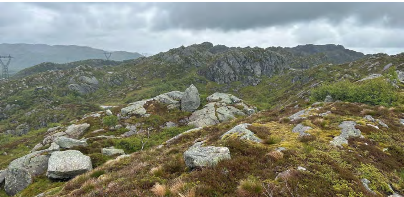
Figur 5-31: Eksisterende kraftledning (som skal erstattes av utredet tiltak) er synlig gjennom delområdet. Her sett sørøst fra Storafjellet (bilde tatt av Statnett).
