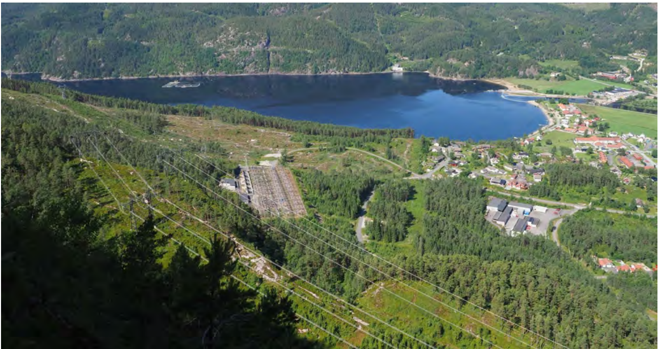
Figur 5-6: Terrenget ligger over delområde LA2a. Her med sikt mot trafostasjon og Tonstad sentrum i nordenden av Sirdalsvatnet.
