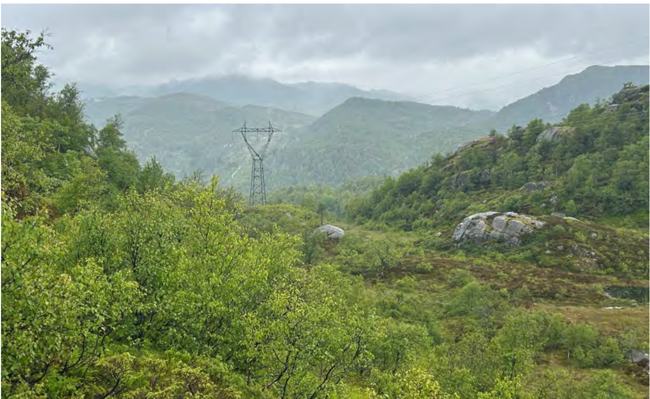
Figur 5-25: Eksisterende ledningstrasé passerer litt nord for Hommeknuten (bilde tatt av Statnett)
