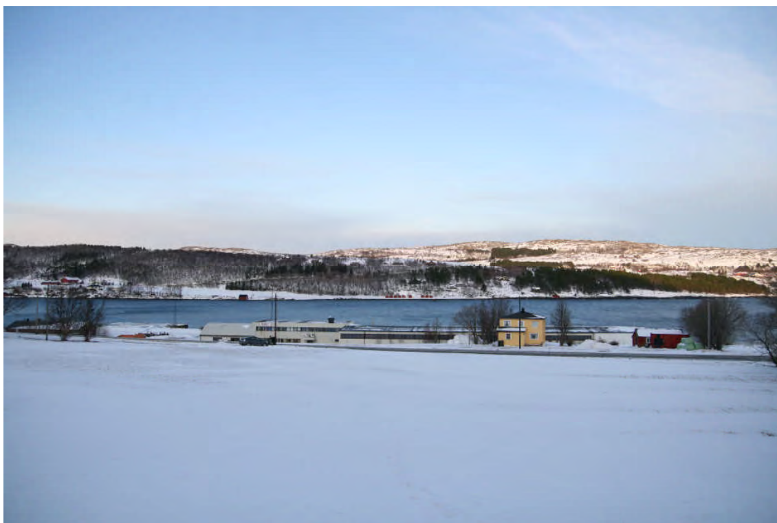
Figur 30. Utsikt fra muffestasjonen mot hytter på motsatt side av Selvbukta. Foto: Statnett
