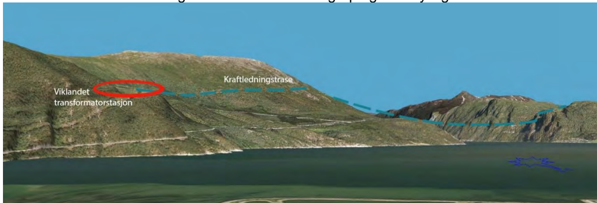
Figur 19 : Viklandet transformator ligger på et naturlig inntrukket platå i fjellsiden og er ikke synlig fra fjorden. Her sett fra fjordkanten på Sunndalsøra.
