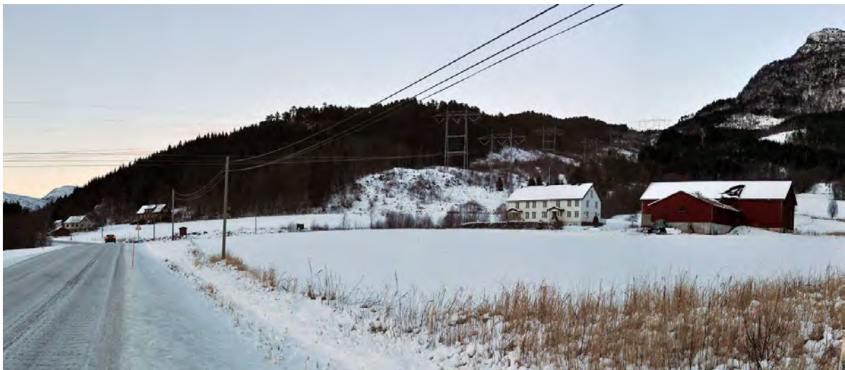
Figur 17: Ned mot Ålvundeid fra øst er ledningsen synlig fra Viset gård. Ny trasé blir som i dag, men med marginalt høyere master. Dagens situasjon øverst, og ny nederst.
