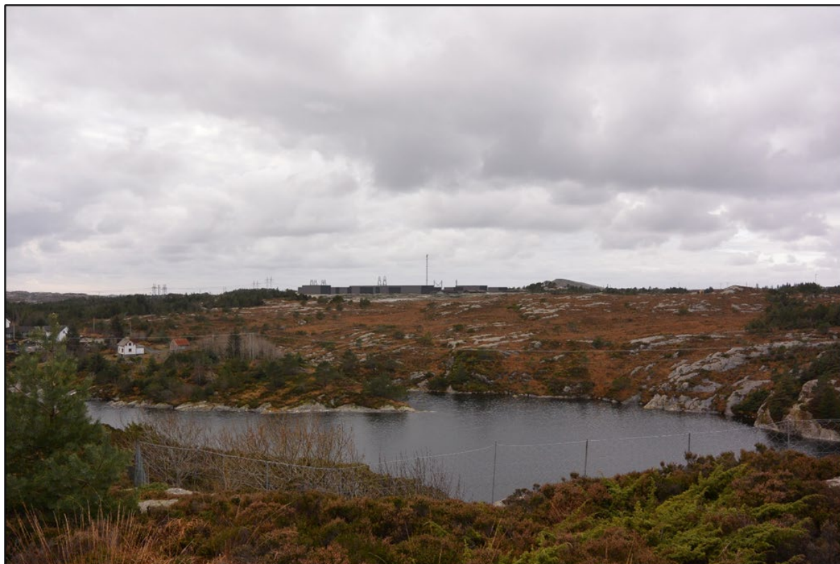
Figur 21: Dagens utsikt fra bebyggelsen på Rossnes (øverst) Visualisering av stasjonsområdet, sett fra fra boligfeltet på Rossnes øst (nederst). Viser bygningsmasse hvor GIS-bygget har en lengde på 165 meter, omsøkte bygg er ca. 216 meter langt.
