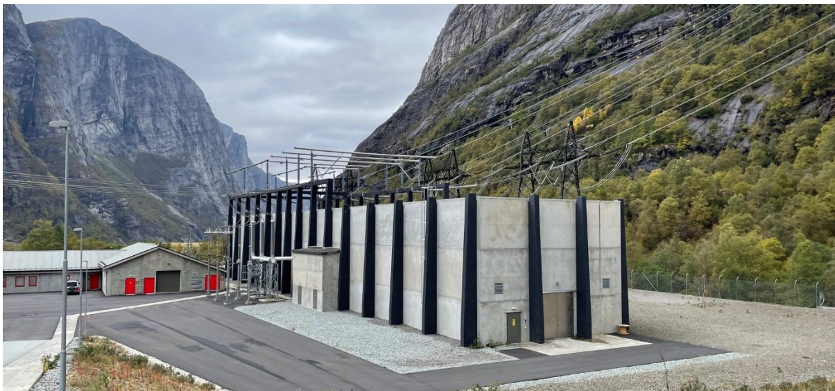
Figur 7: GIS-bygg fra Lysebotn. Omsøkt nytt GIS-bygg på Øygarden stasjon planlegges med samme materialbruk og farger. Statnett standard kontrollbygg ses til venstre i bildet.
