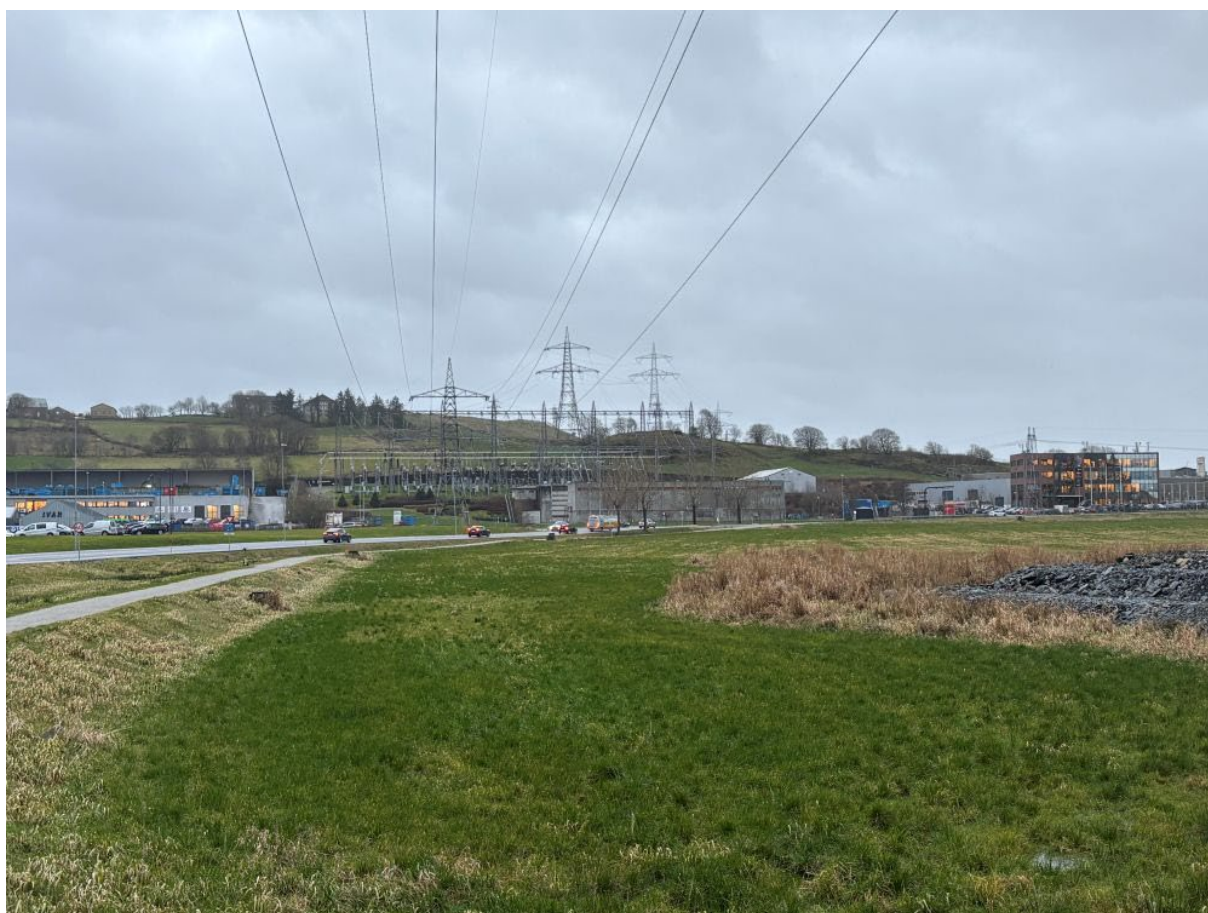
Figur 20 Eksisterende Bærheim transformatorstasjon, deler av IVARs forbrennings- og avfallshånderingsanlegg og deler av eksisterende næringsbebyggelse sett fra nord. Bildet er tatt i desember 2025.
