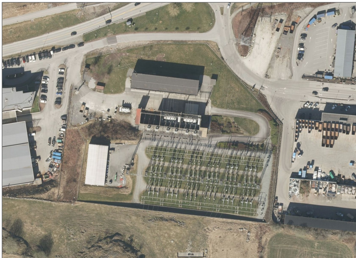
Figur 13 Eksisterende Bærheim transformatorstasjon. Kilde: Norgeskart.
