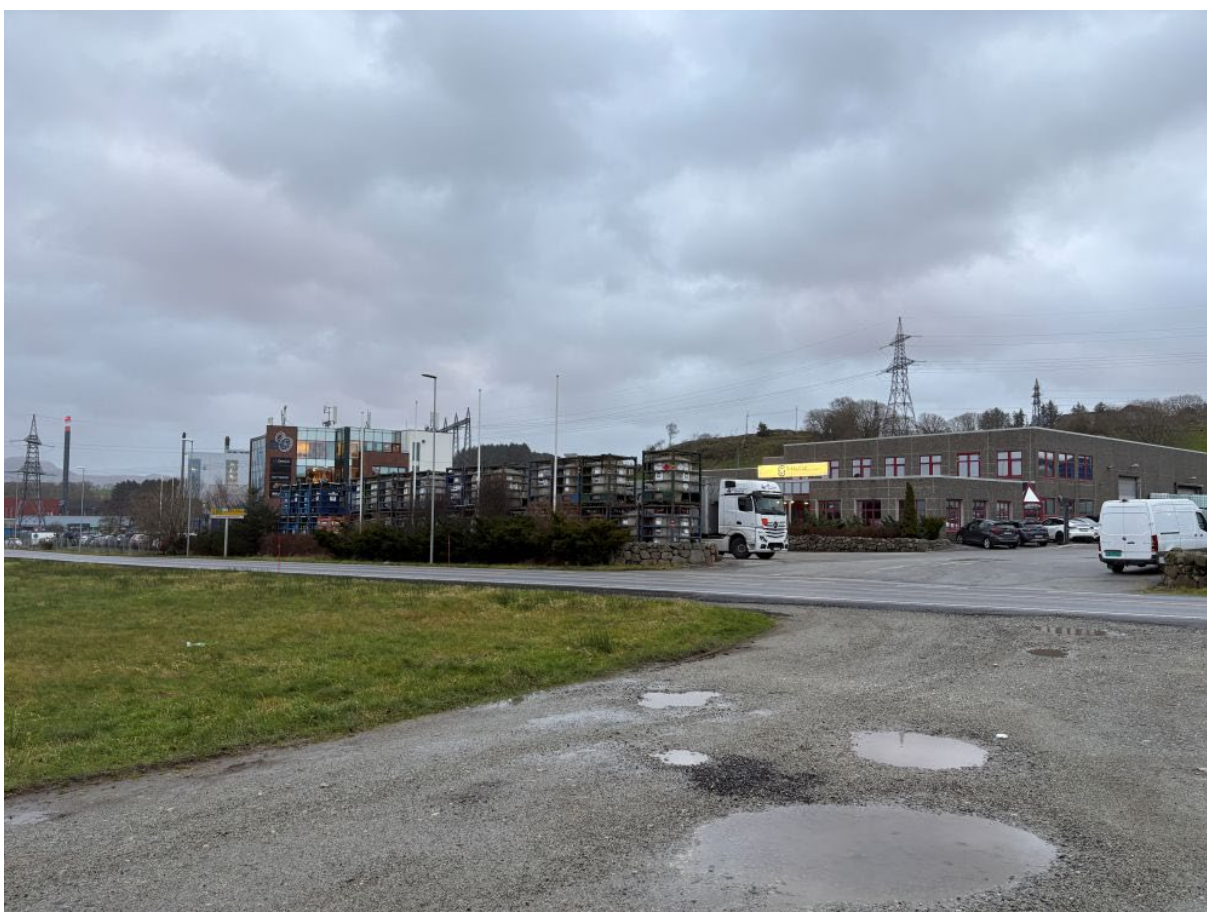
Figur 22 Eksisterende næringsområde, sett fra nord. Bærheim transformatorstasjon ligger bak næringsbebyggelse. Bildet er tatt i desember 2025.
