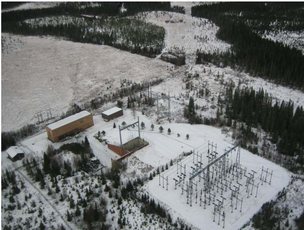
Figur 17. Oversiktsbilde over dagens Namsos transformatorstasjon i Overhalla.
