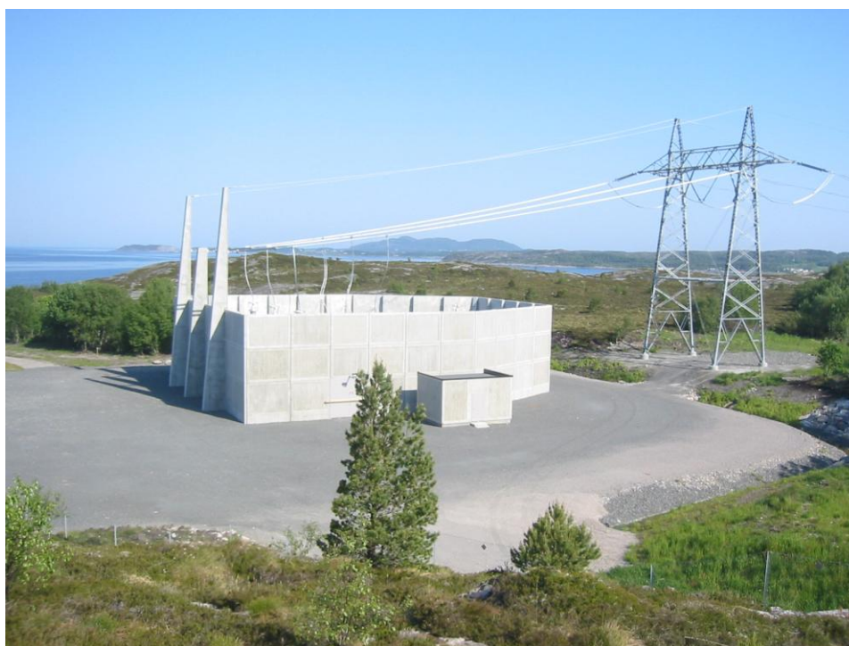
Figur 5. Eksempel på muffestasjon. Bildet er fra Hamneset i Fræna kommune, der forbindelsen går over fra luftledning til kabel for å føres over til Aukra. Muffestasjonen ved kryssing Trondheimsfjorden vil bli noe større, fordi fjorden krysses med to kabelsett (foto: Statnett).
