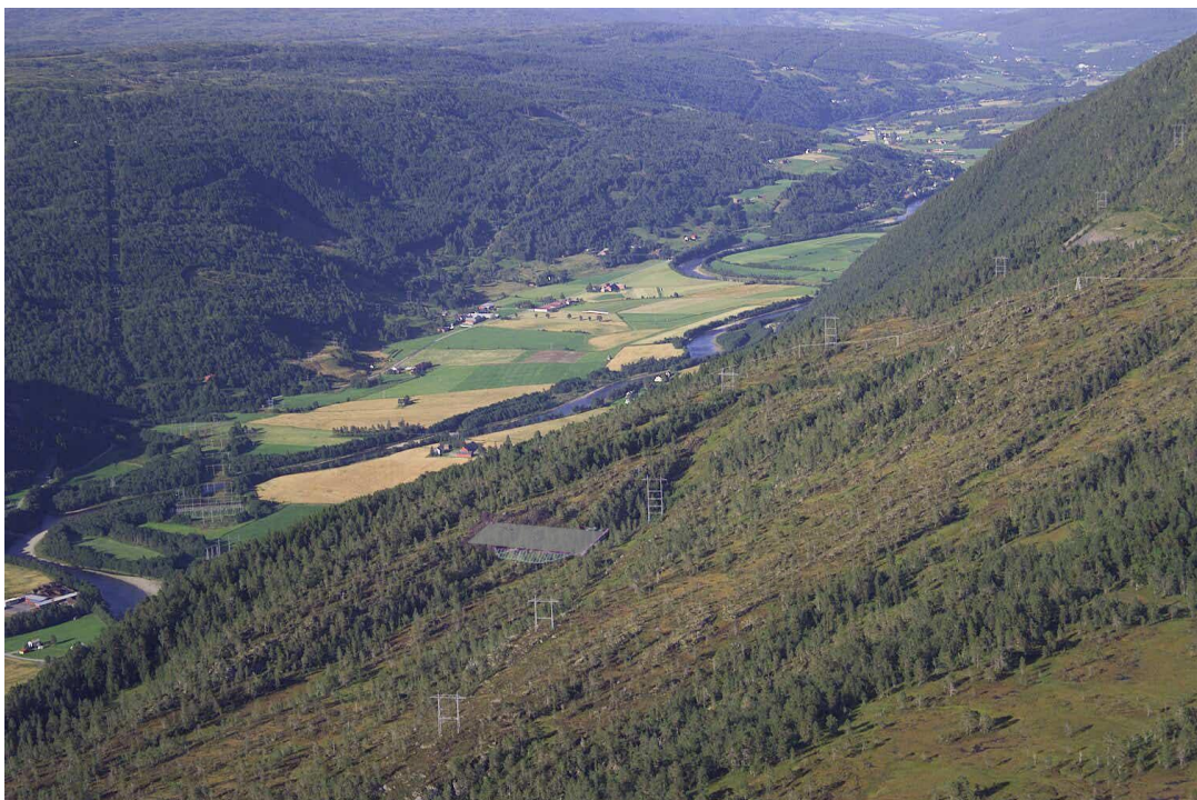
Figur 19. Flyfoto over aktuell lokalitet for Trollheim transformatorstasjon. Stasjonens plasseringen er illustrert med en skravert flate i bildet. Faktisk arealbeslag vil kunne avvike (Foto: Statnett).
