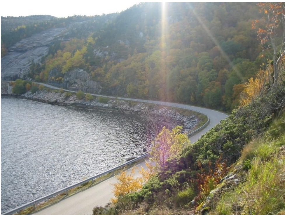
Figur 12. Skreabukta i Agdenes kommune. Aktuell lokalitet for muffestasjon og reaktorlegg ligger på høyden bildet er tatt fra (Foto: Statnett).
