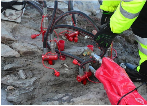
Figur 5: Eksempel på bergoppvarming på vinterstid med væskebåren varme 4 for å øke anleggsperioden inn i vinteren
