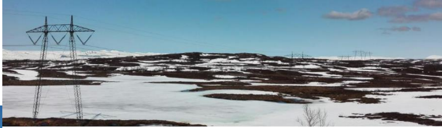
kraftledningen som krysser over Storfjellet (foto: Sindre Efterstøl)
