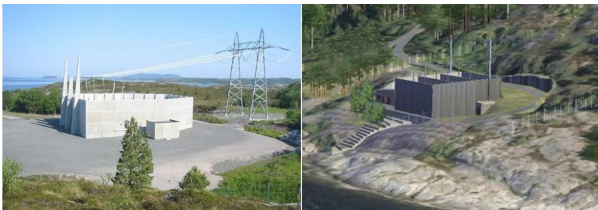
Figur 14: Eksempler på muffeanlegg for 420 kV kabler.
