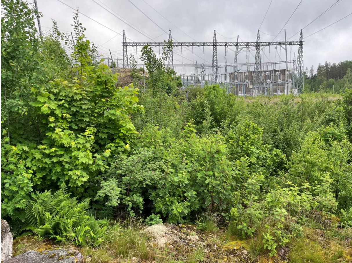
Figur 6 Deler av areal for omsøkt permanent masselager nord for Hof transformatorstasjon. Vegetasjonen består av treoppslag i det som er båndlagt areal under Ledes 132 kV ledningsforbindelse mellom Skolleborg og Hof.
