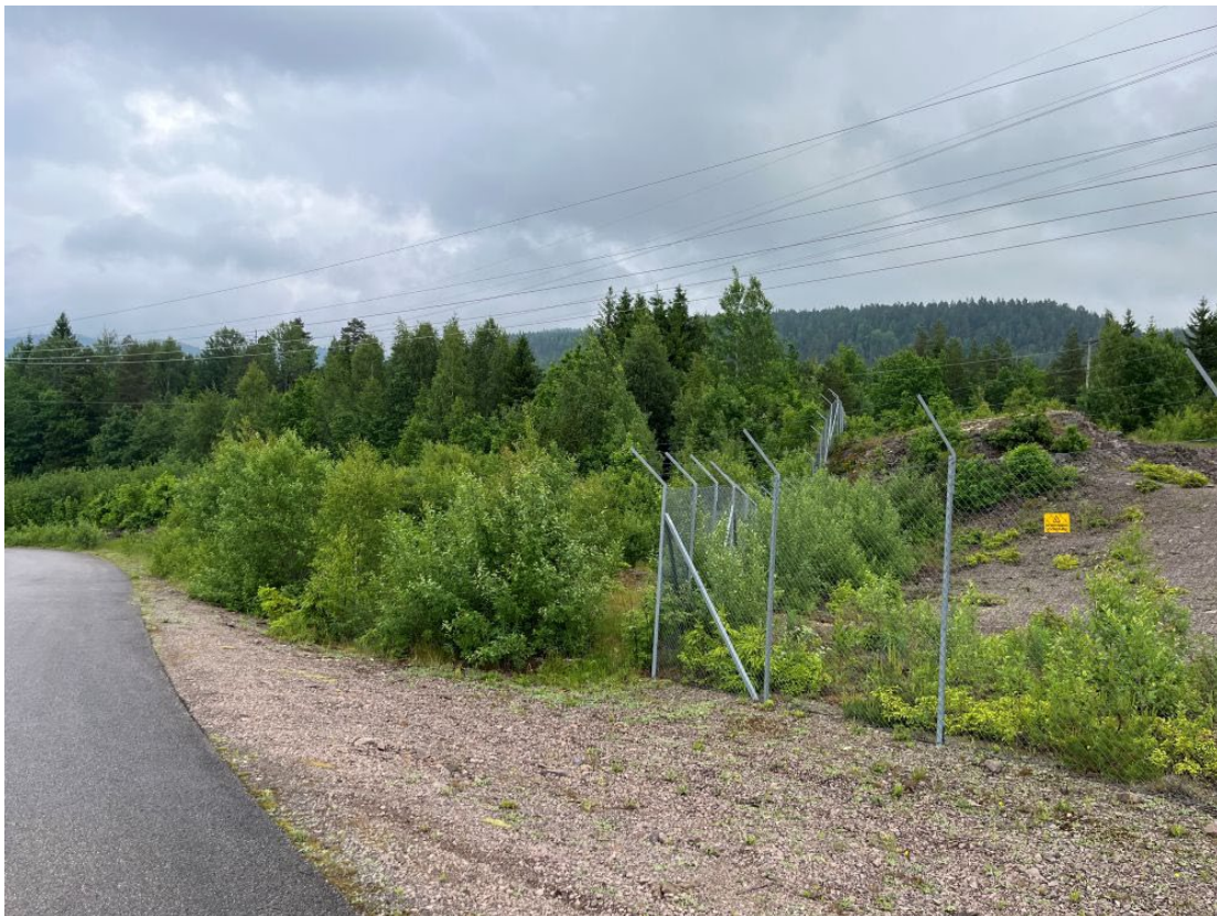
Figur 5 Permanent masselager planlegges utenfor stasjonsgjerdet til Hof transformatorstasjon. På bildet ses areal bak Ledes 132 kV ledning (nærmeste ledning). Bildet er tatt fra adkomstvei til Hof transformatorstasjon mot nordøst.
