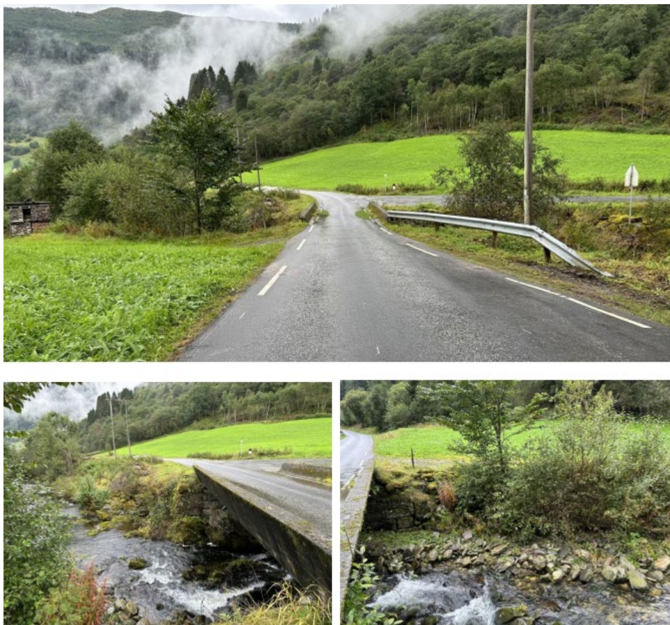
Figur 17: Ovrisdalsbru over Vikja. Kilde: Sweco, 2023.
